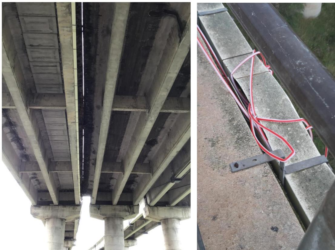
*Figura 11.2. Canaletta in VTR ancorata alla trave di bordo in corrispondenza del by-pass e dettaglio della canaletta e delle staffe di ancoraggio al cordolo*
