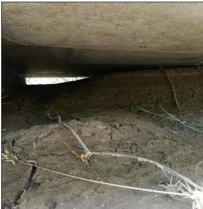
Immagine 4.2 – Attraversamento critico Fiume Morello (interno scatolare)
