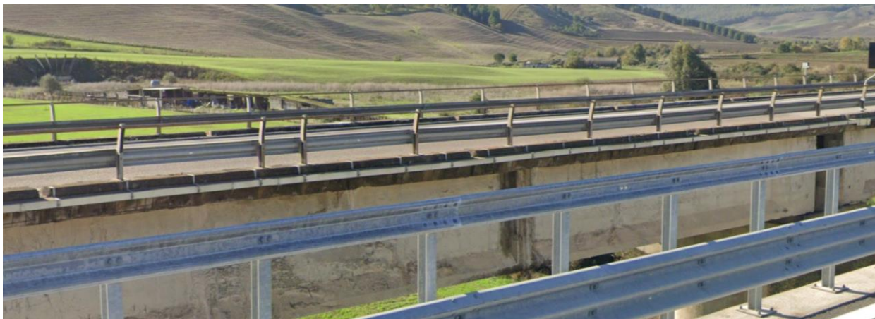
Figura 11.1. Canaletta in VTR ancorata al cordolo lato interno per l'intero sviluppo del viadotto (vista dalla carreggiata CT-PA)
