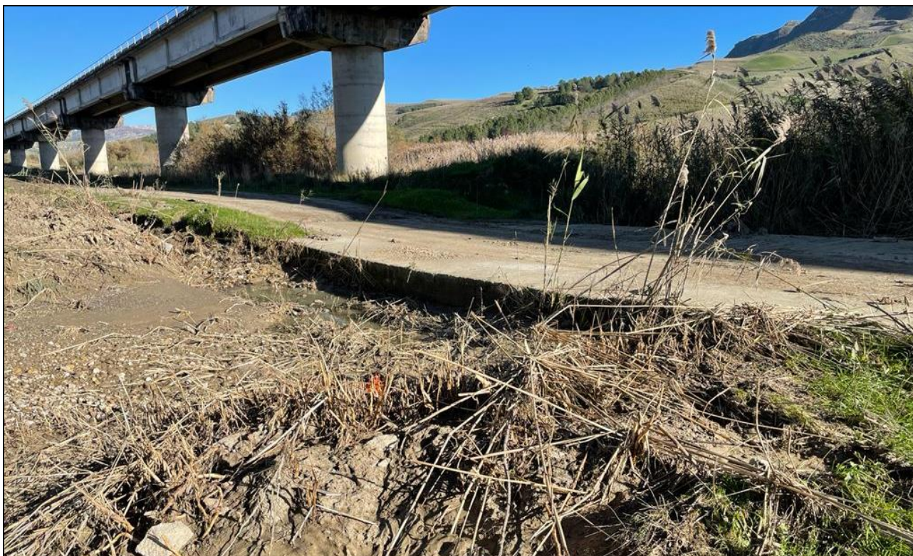
Figura 4.1 – Attraversamento critico Fiume Morello
