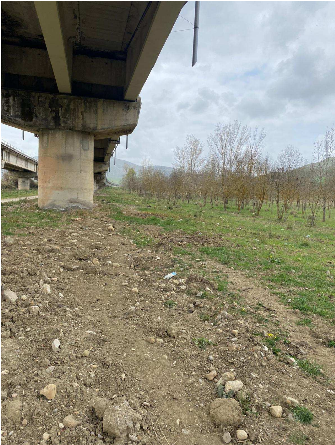
FOTO N. 21- da questo punto si rende necessario realizzare una nuova pista di cantiere ubicata tra i piloni dell'autostrada e la prima fila di alberi che dagli elaborati di progetto non verranno interferiti vedi foto seguente con indicato l'ingombro della nuova stradella provvisoria
