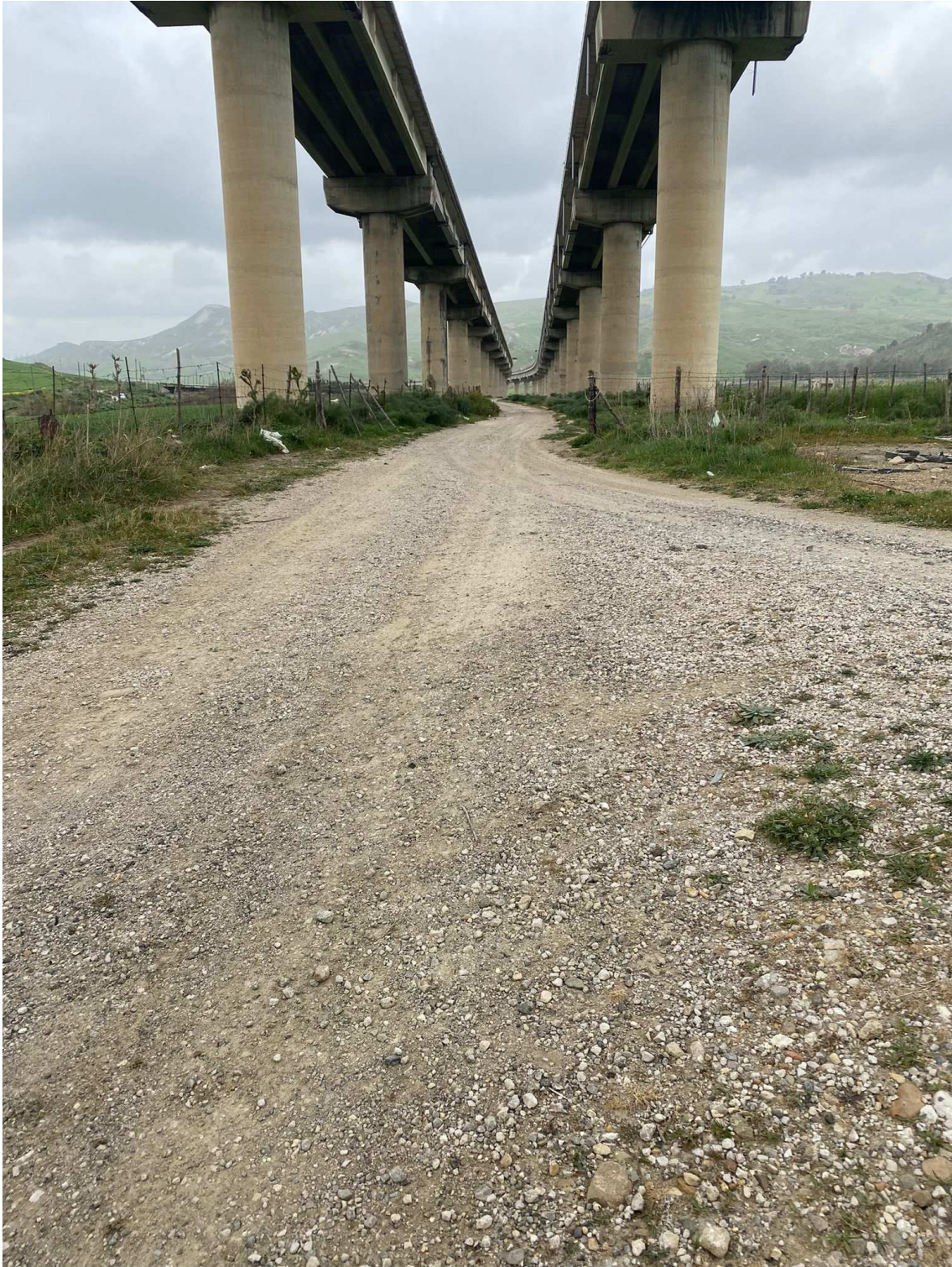
FOTO N. 12 Da questo punto si abbandona la strada di cantiere asfaltata e la pista di cantiere esistente è in terra battuta su cui non sarà necessario prevedere opere di sistemazione ed adeguamento
