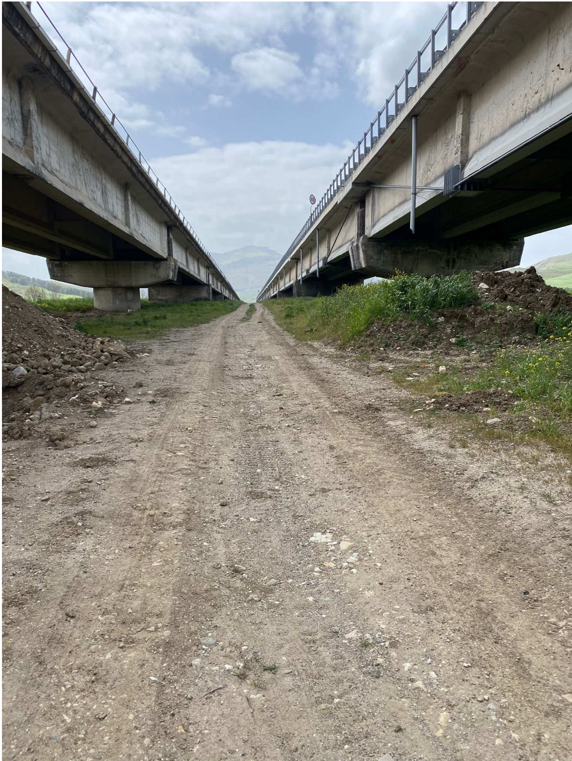
FOTO N. 34 - Pista di cantiere esistente e perfettamente adeguata allo scopo
