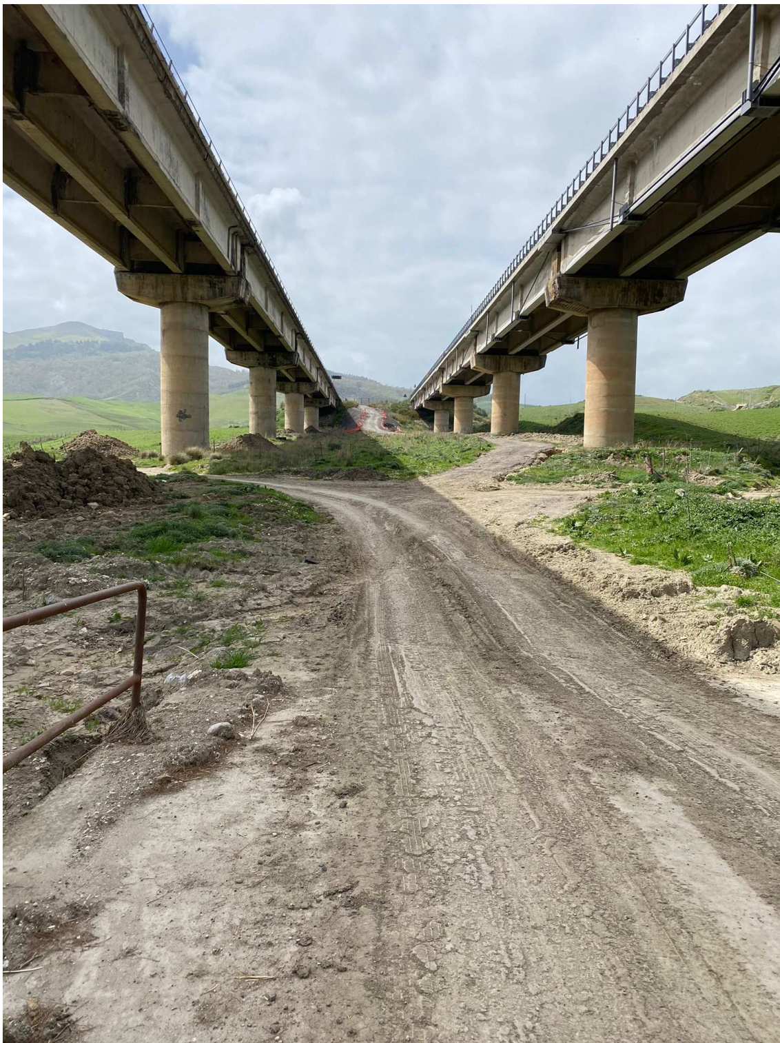
FOTO N. 31 - Pista di cantiere esistente e perfettamente adeguata allo scopo
