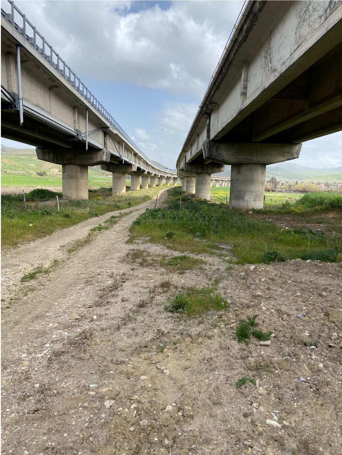
FOTO N. 35 - Pista di cantiere esistente e perfettamente adeguata allo scopo
