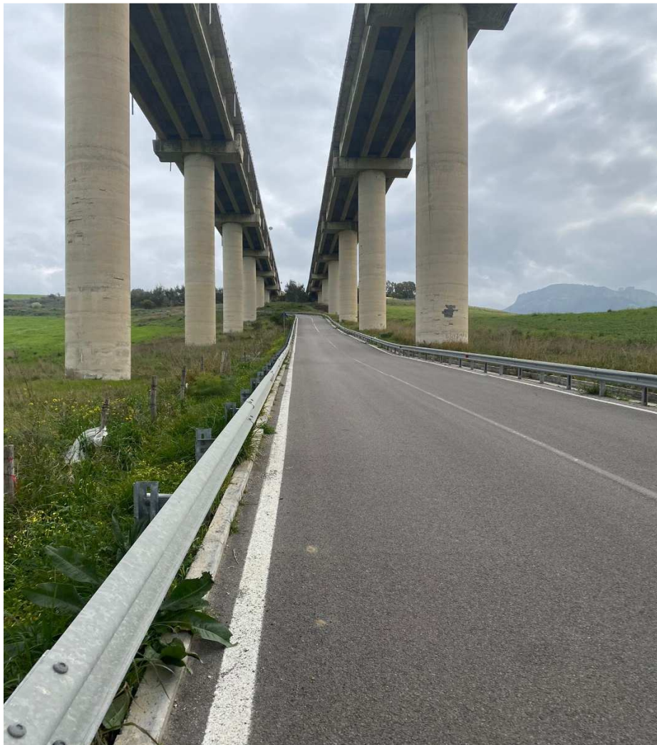
FOTO N. 1 Pista di cantiere esistente ed asfaltata. In questo tratto non sono previsti allargamenti di nessun tipo
