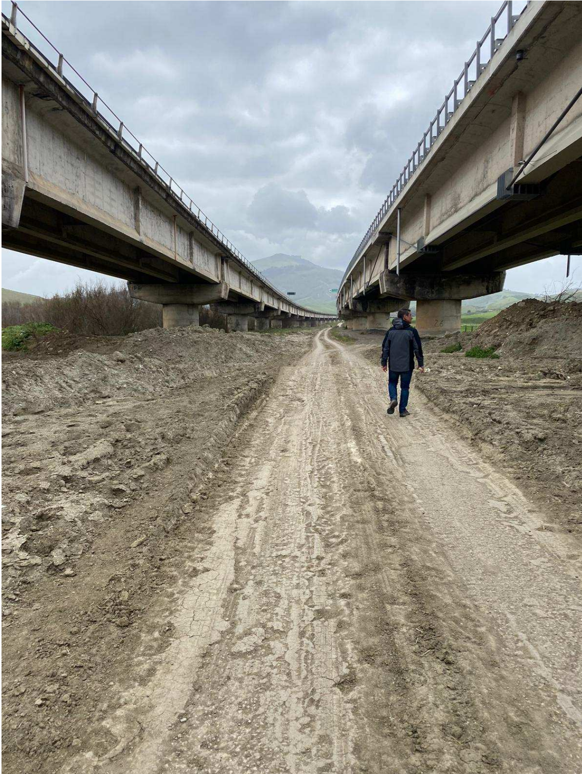
FOTO N. 23 - Pista di cantiere esistente di larghezza adeguata
