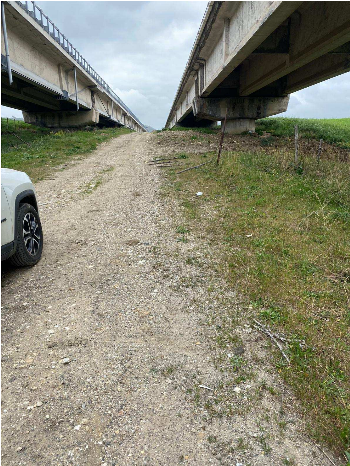
FOTO N. 20 Pista di cantiere esistente adeguata allo scopo
