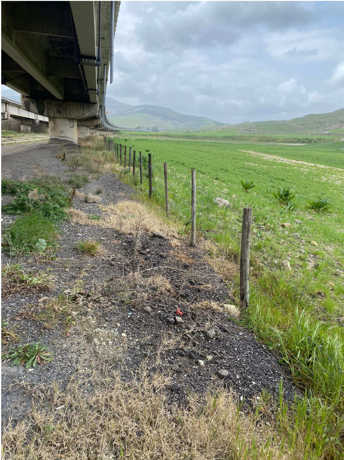
FOTO N. 24 – In questo tratto si rende necessario realizzare una pista parallela a quella esistente. Come si può vedere si tratta di un'area coltivata a grano che verrà restituita al proprietario a fine lavori per ripristinare l'attuale coltivazione.
