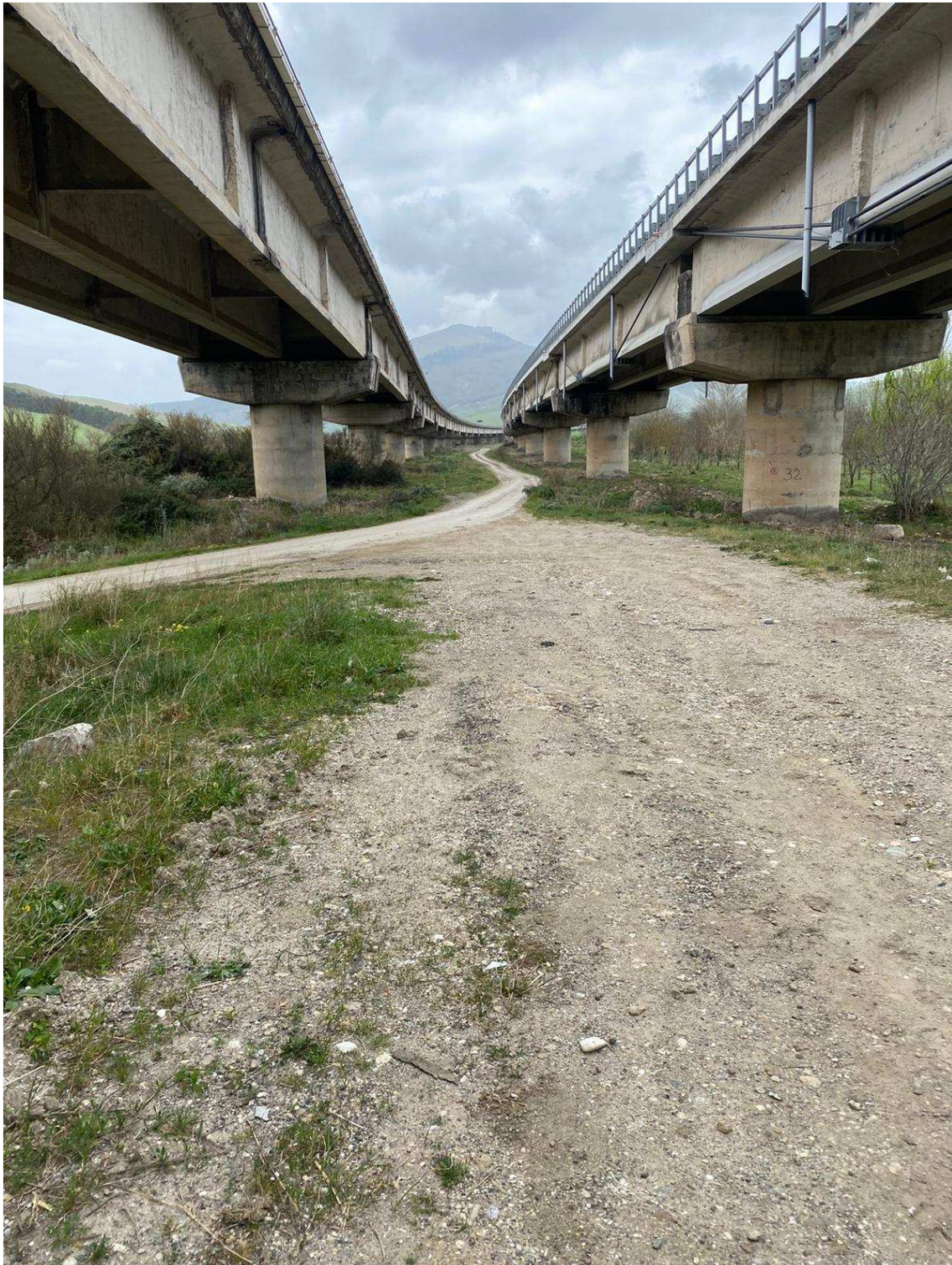
FOTO N. 19 – Pista di cantiere esistente adeguata allo scopo
