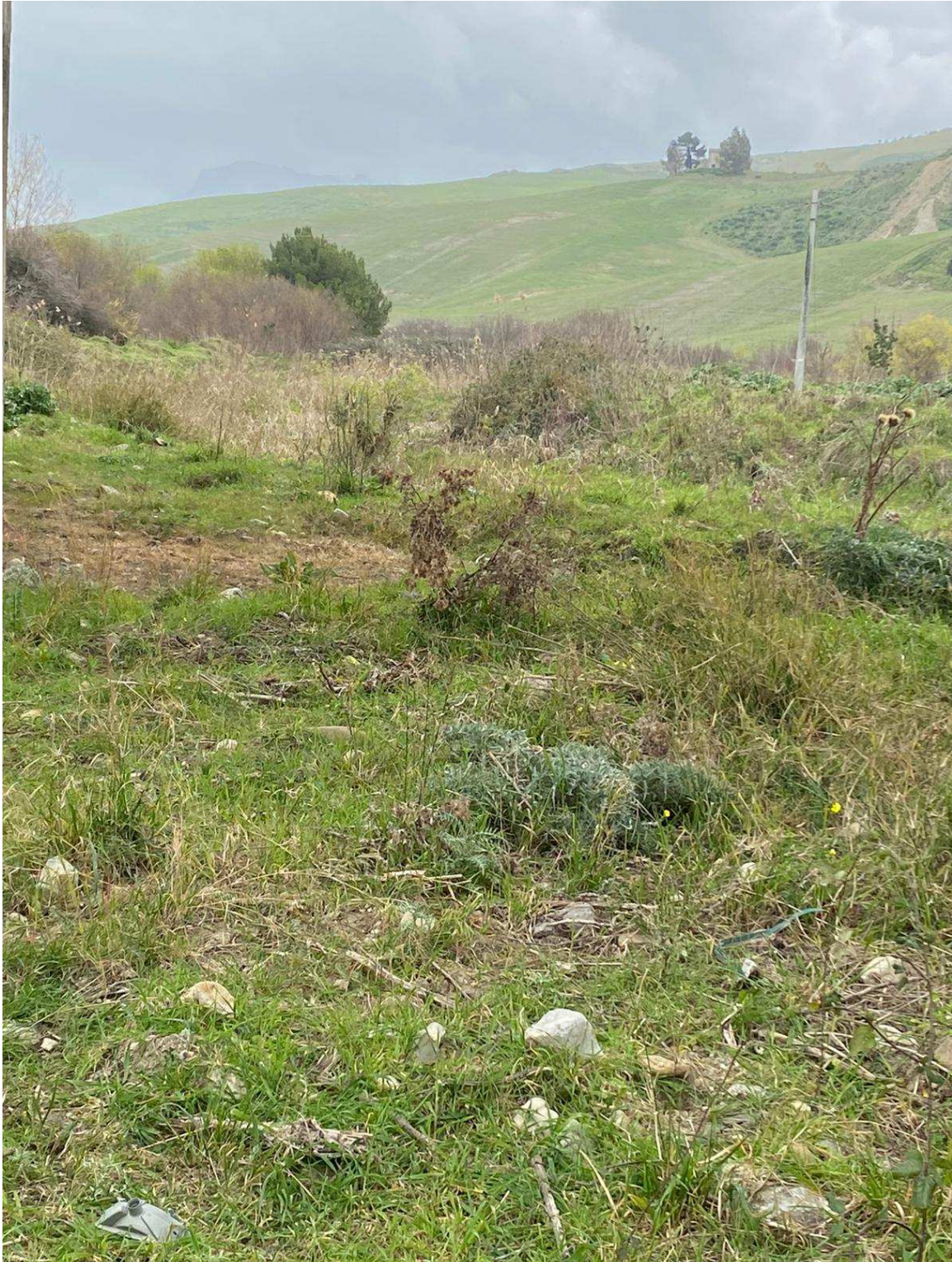
FOTO N. 22 - Alveo del Fiume Morello in stato di degrado
