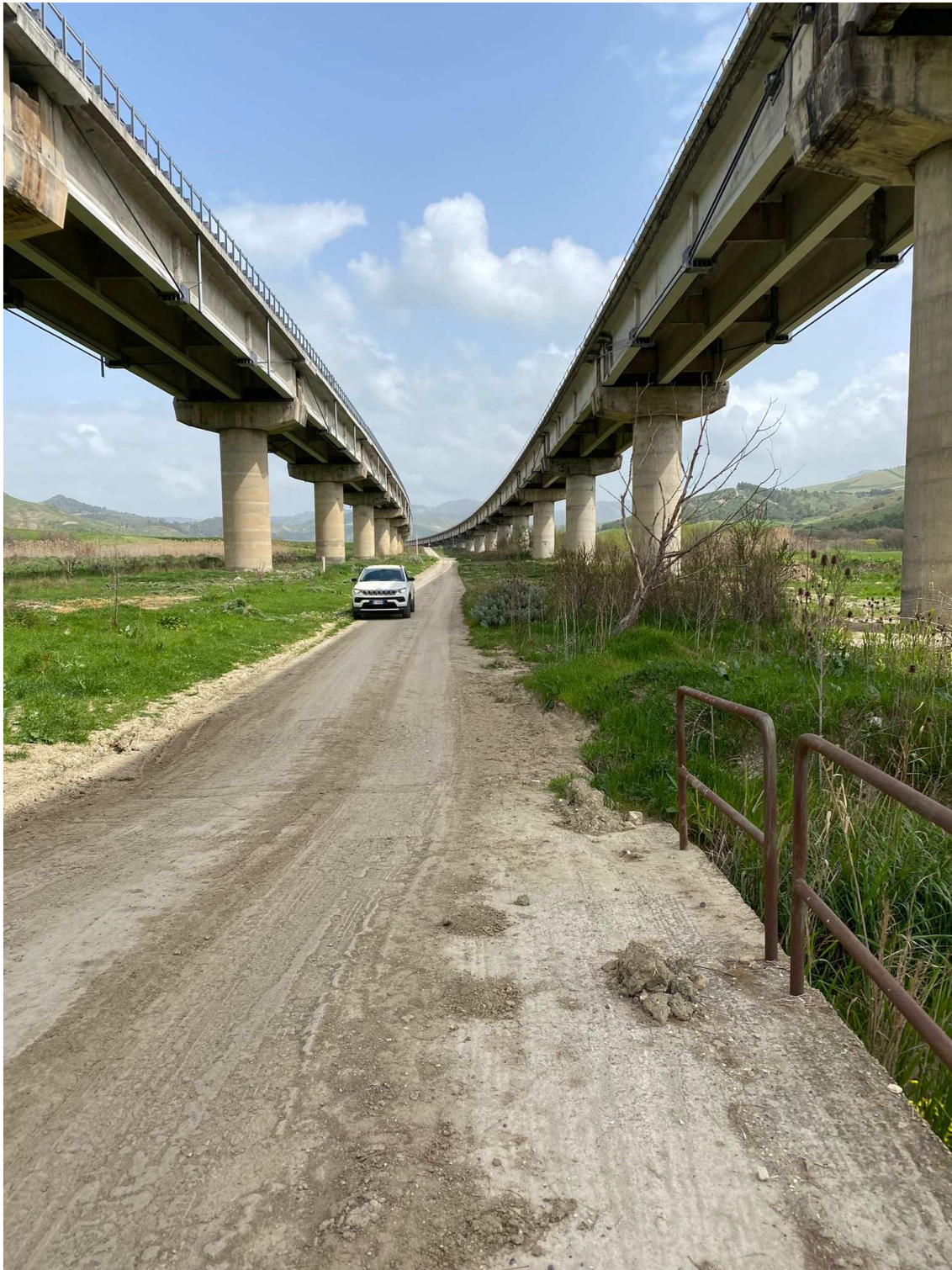
FOTO N. 30 – Pista di cantiere esistente e perfettamente adeguata allo scopo
