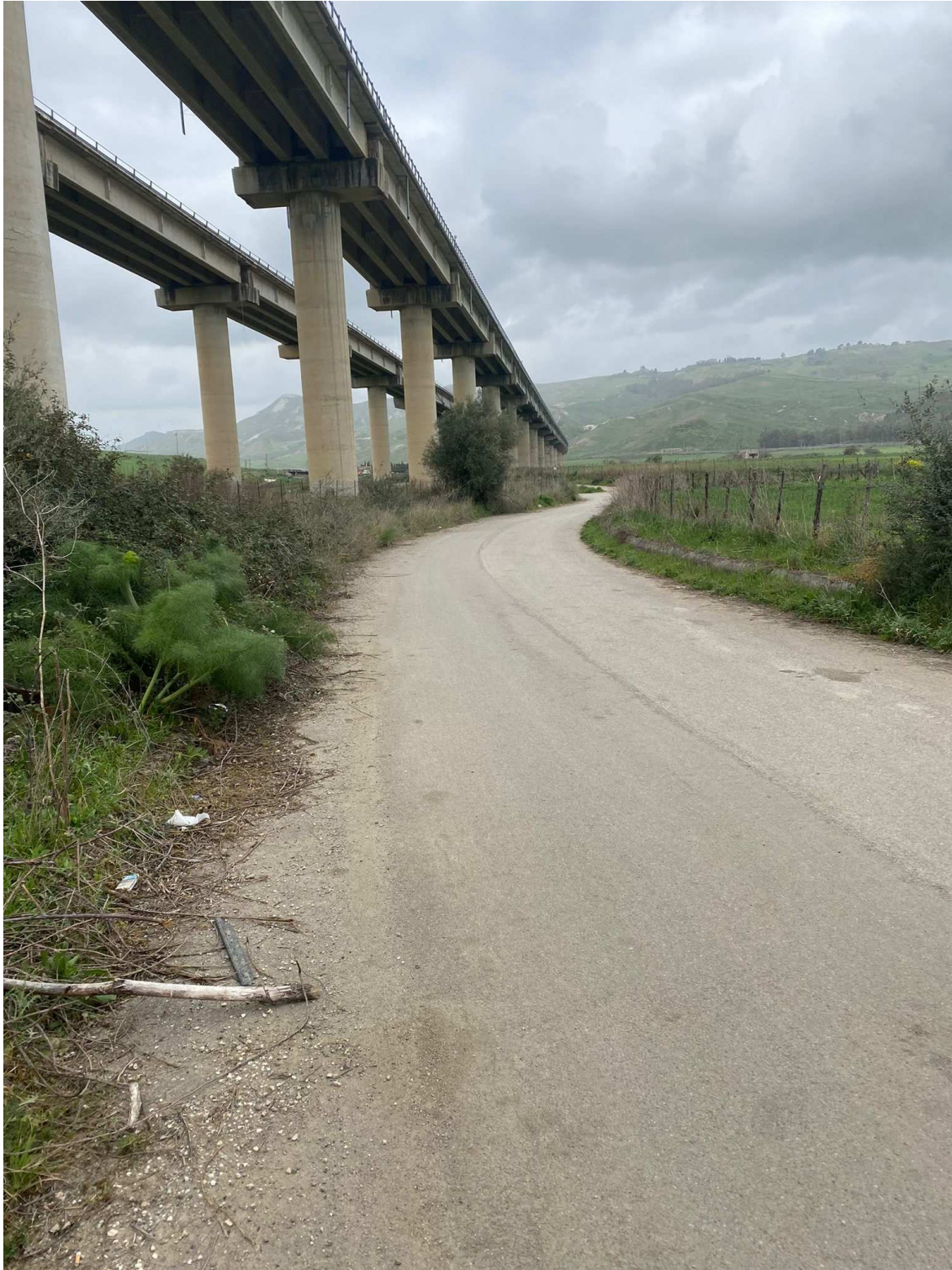
FOTO N. 11 Strada di cantiere esistente ed asfaltata su cui non sarà necessario prevedere opere di sistemazione ed adeguamento
