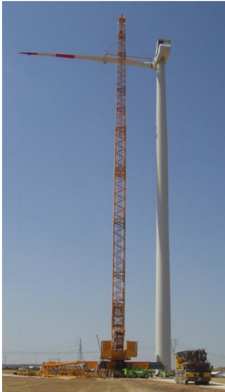
Figura 43 Montaggio pala
