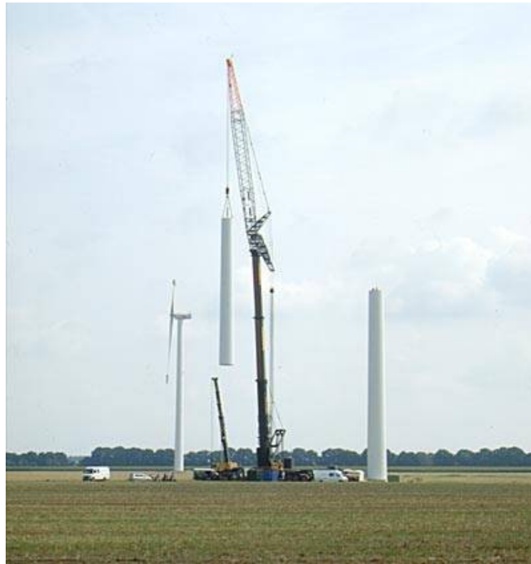
Figura 36 Montaggio secondo troncone torre
