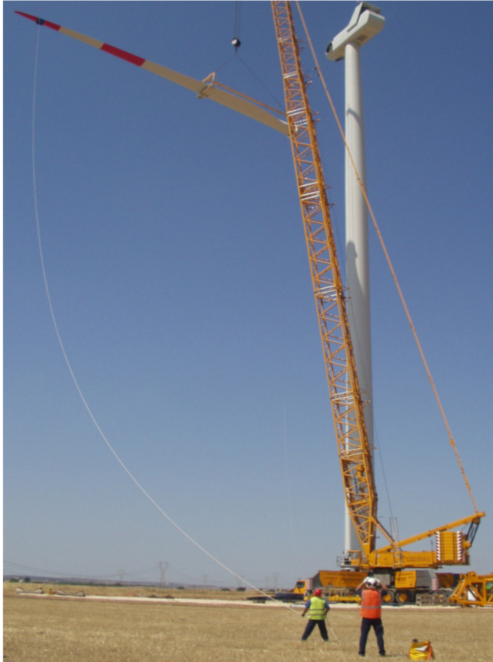
Figura 42 Montaggio pala
