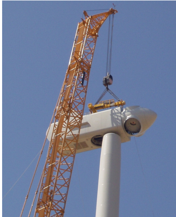
Figura 40 Montaggio Navicella
