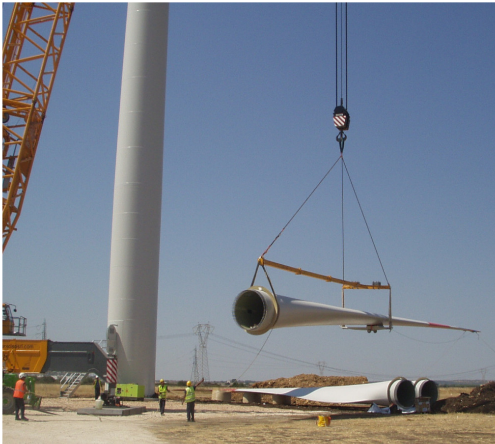
Figura 41 Montaggio pala
