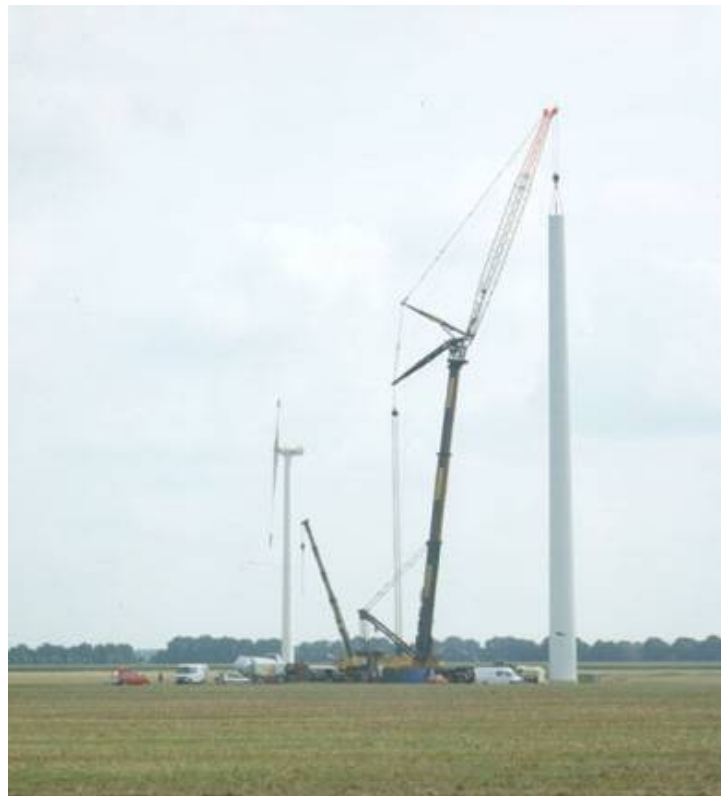
Figura 37 Montaggio secondo troncone torre
