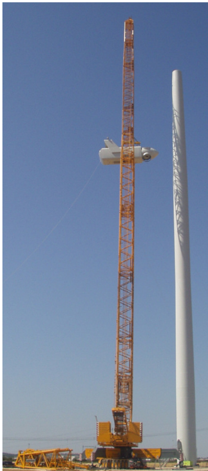
Figura 39 Montaggio Navicella
