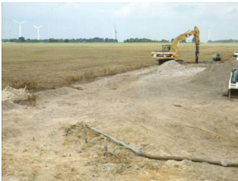
Figura 33 Preparazione pista/piazzola
