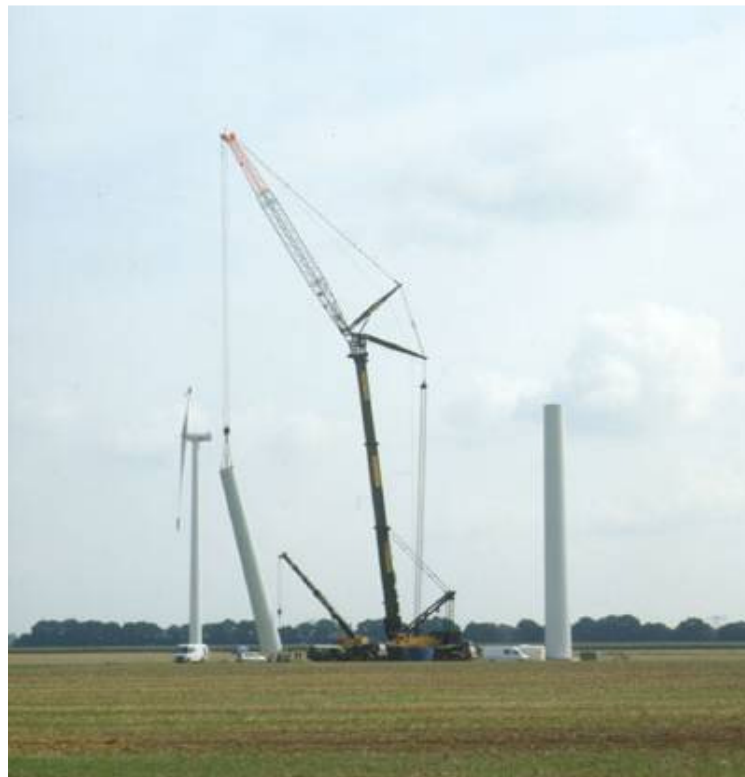
Figura 35 Montaggio secondo troncone torre
