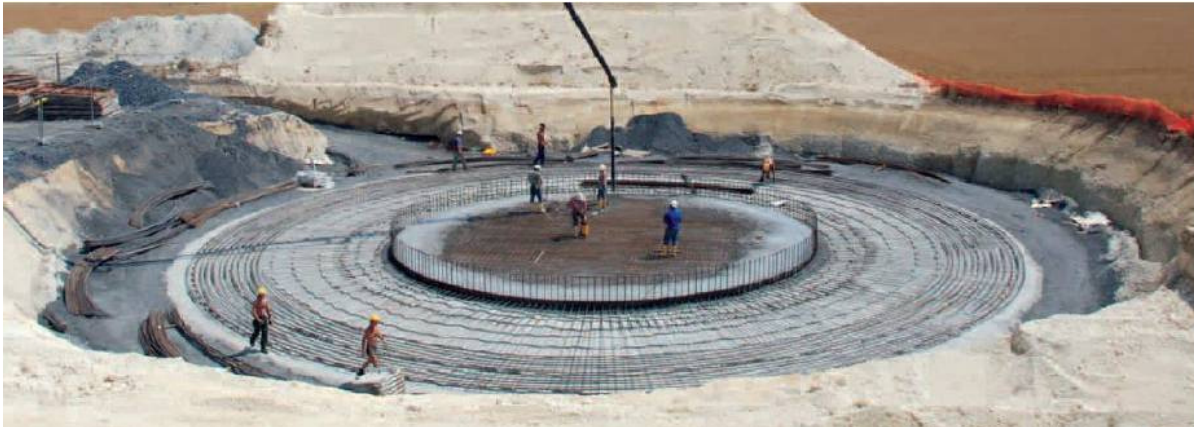
Figura 34 Preparazione fondazione
