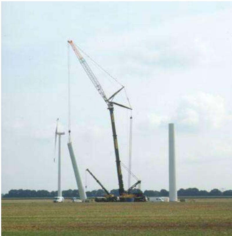
*Figura 6 Montaggio secondo troncone torre*
