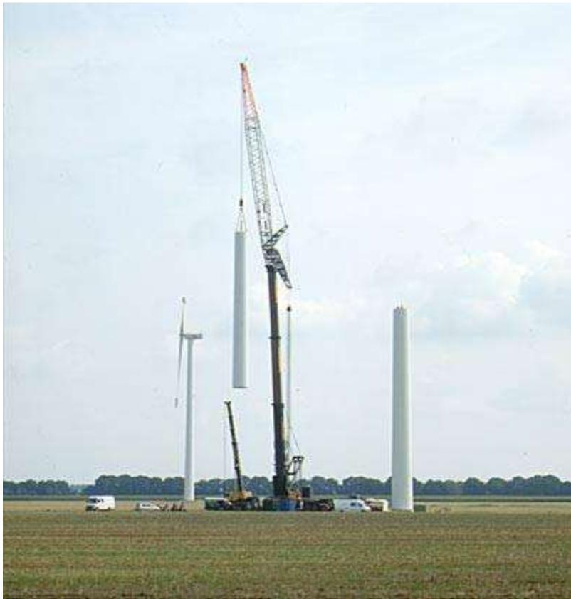
*Figura 7 Montaggio secondo troncone torre*
