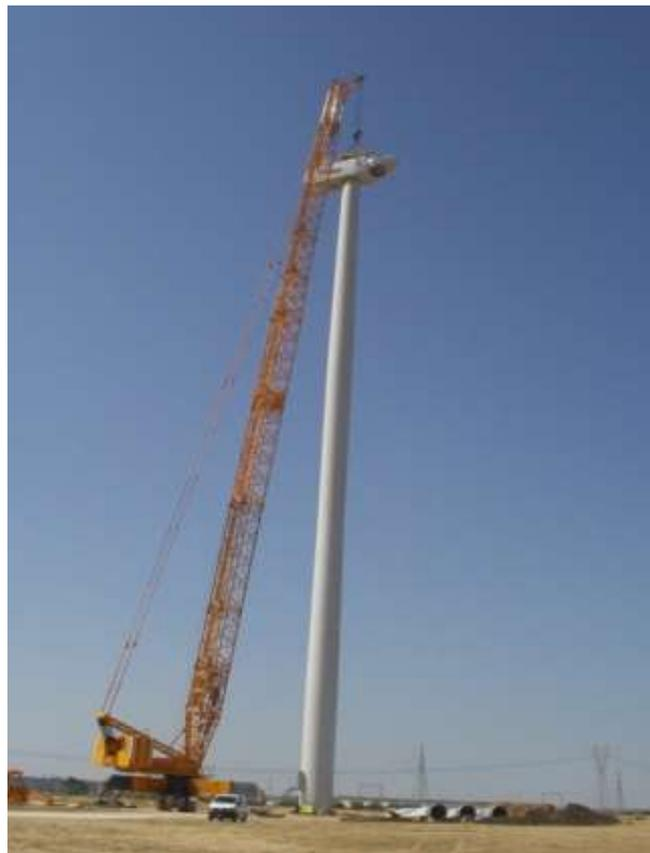
*Figura 11 Fasi di montaggio navicella Vestas*
