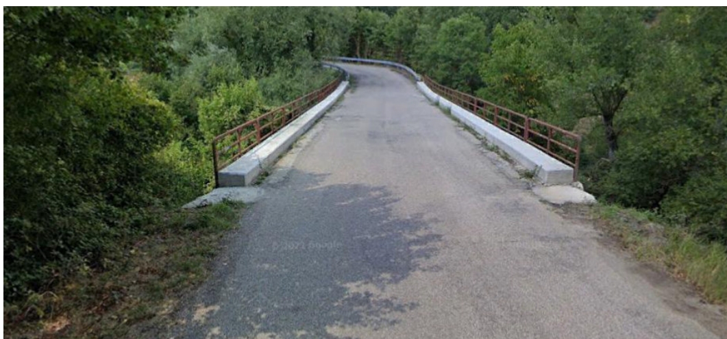
Vista del Torrente Fiumarella nel tratto di interferenza con il cavidotto
