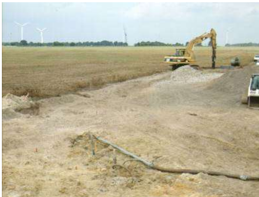
Figura 4 Preparazione pista/piazzola
