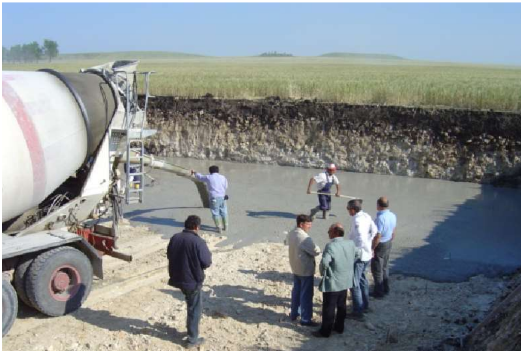
Figura 2 Getto magrone a scavo fondazione completato
