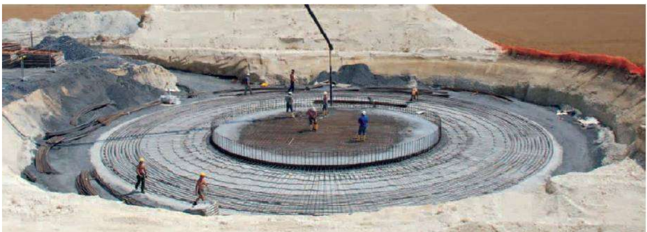
Figura 3 Preparazione fondazione
