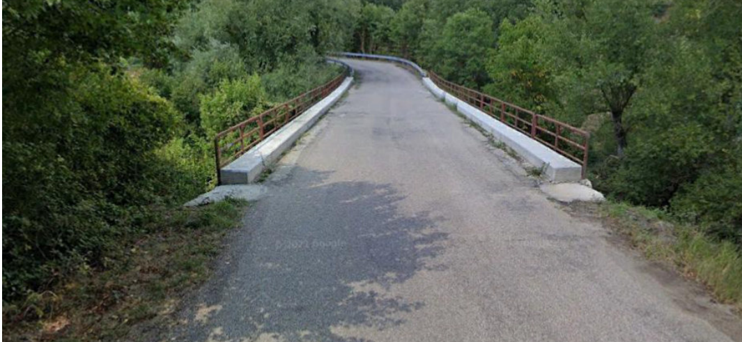
Figura 10_Vista del Torrente Fiumarella nel tratto di interferenza con il cavidotto
