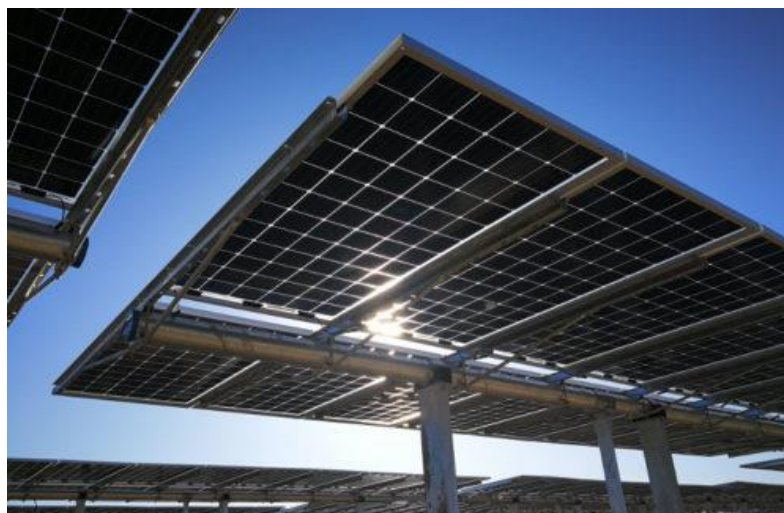
Figura 4.5 Esempio di struttura a tracker monoassiale
