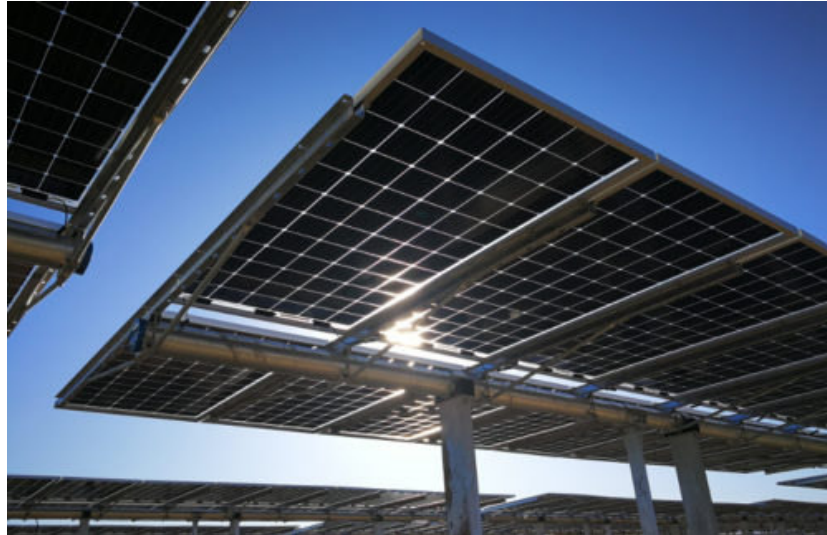
Figura 3.2: Esempio di struttura a tracker monoassiale.
