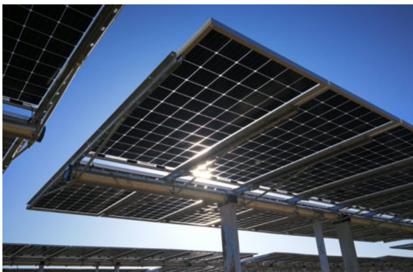
Figura 2.8: Esempio di struttura tipo tracker monoassiale
