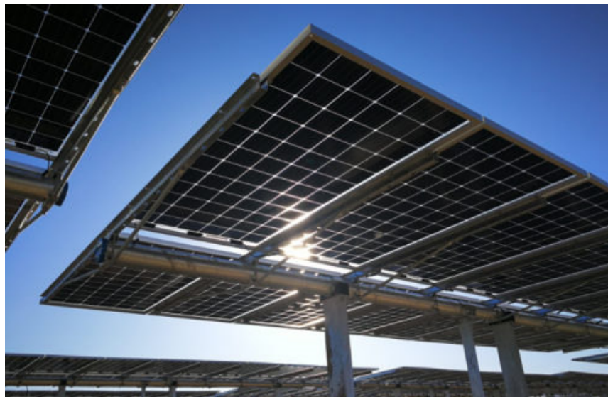
Figura 2.8: Esempio di struttura tipo tracker monoassiale
