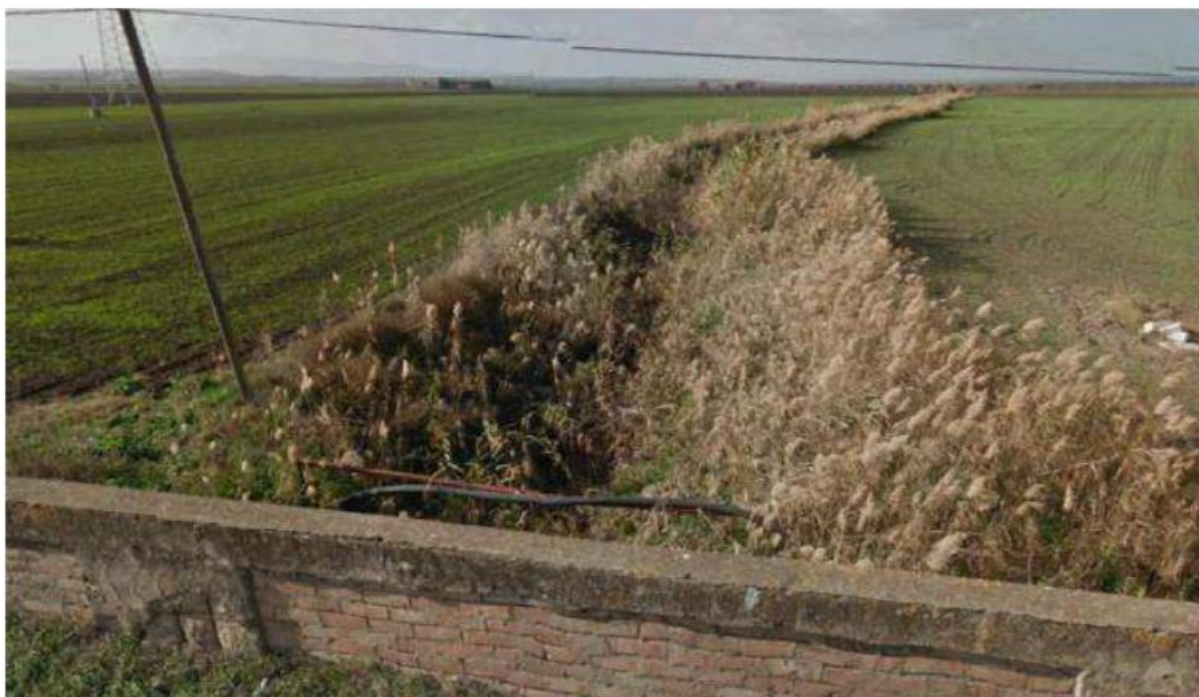
Figura 4.30: C. Ferrante sovrappasso con SP20. Vista verso monte.
