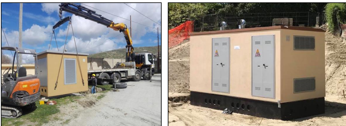
Figura 12 - Fasi di scarico cabine prefabbricate in cav
