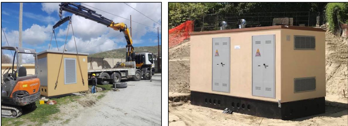
Figura 8 - Fasi di scarico cabine prefabbricate in cav
