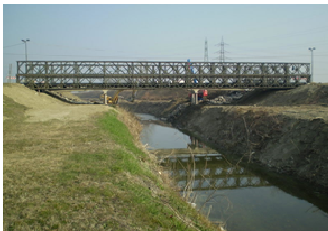
FIGURA 1-1: IMMAGINI ESEMPLIFICATIVE DI UN PONTE BAILEY
