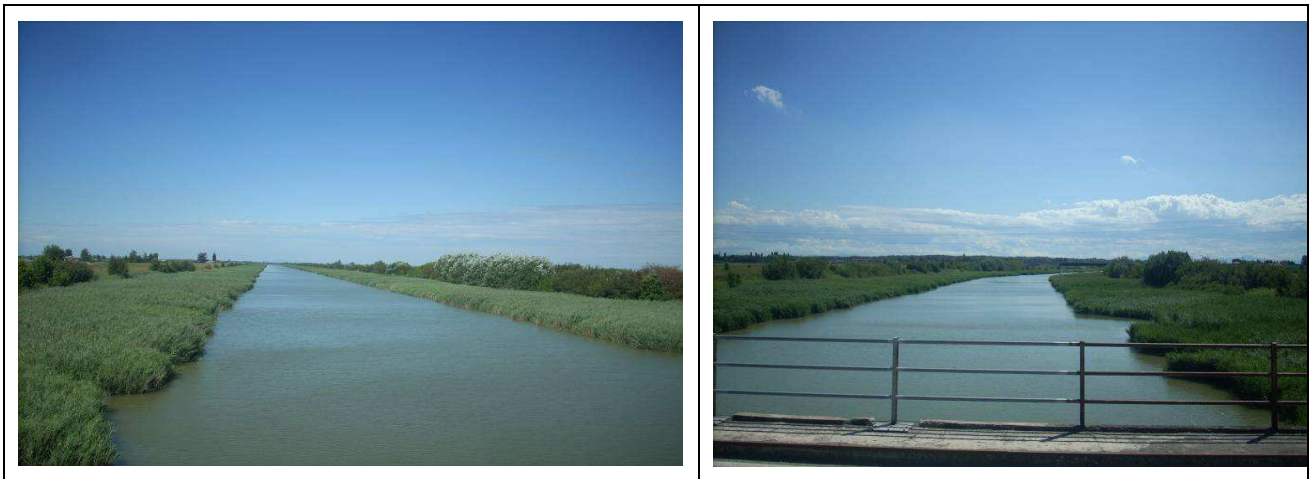
FIGURA 4-3: SCOLMATORE DI RENO NELLE VICINANZE DELL'ATTRAVERSAMENTO AUTOSTRADALE
