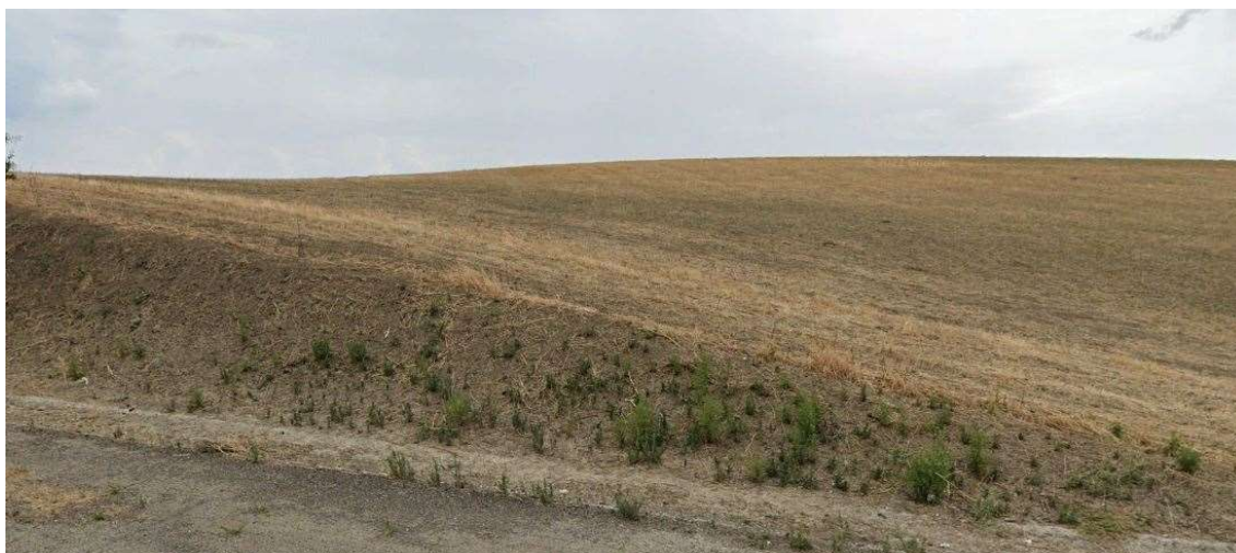
35 – report fotografico stato di fatto areale di intervento
