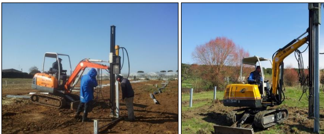
Figura 63 - Tipologia di installazione delle strutture di sostegno dei moduli FTV con macchina battipalo
