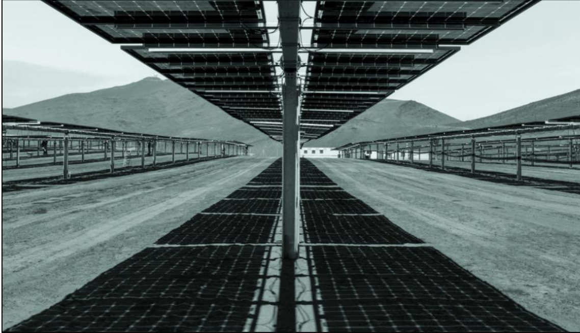
Figura 29 - Esempi di tracker per impianti fotovoltaici
