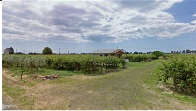
Ricettore R5- Edificio non abitato
