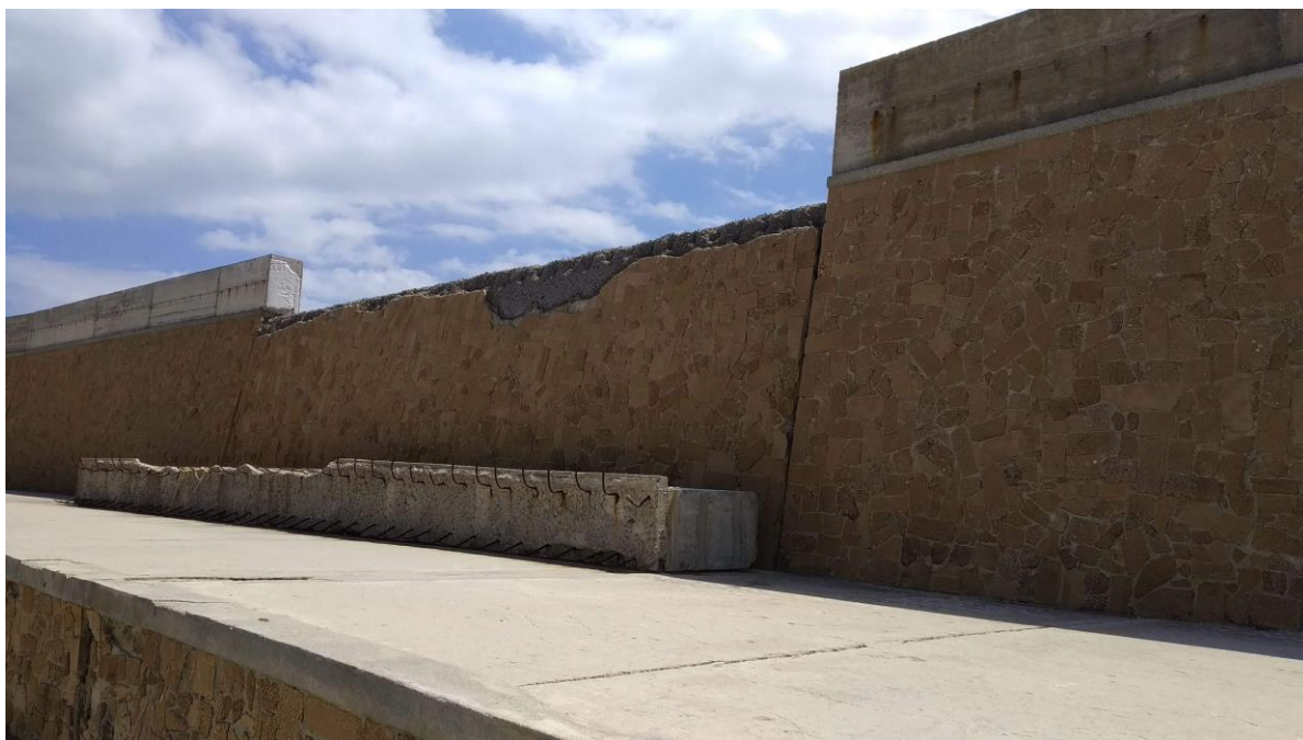
Vista muro paraonde ante operam
