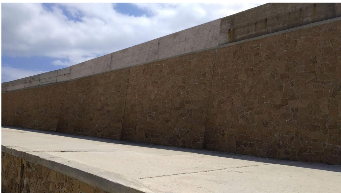
Vista muro paraonde post operam
