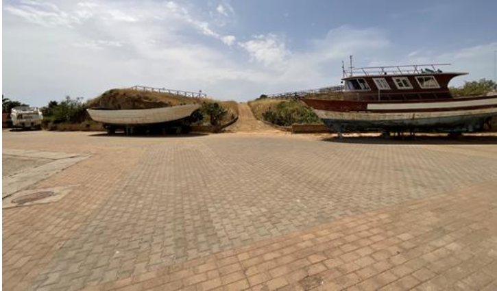
Figura 9-1 Particolare della pavimentazione del piazzale
