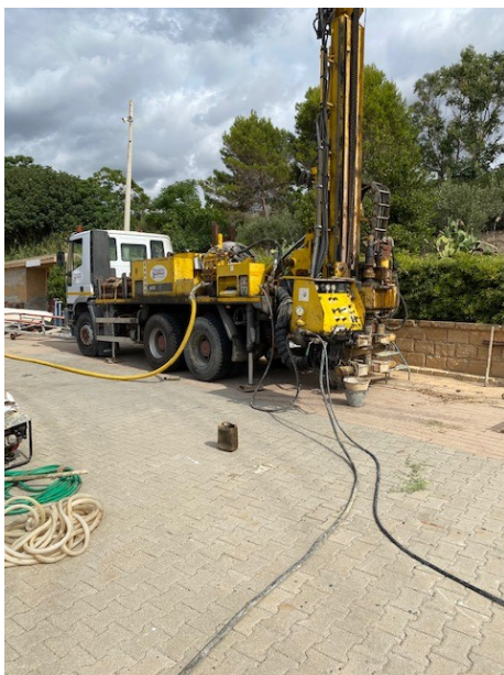
Foto n. 2 Impianto cantiere di perforazione in Stazione ST5 (carotaggio S5)
