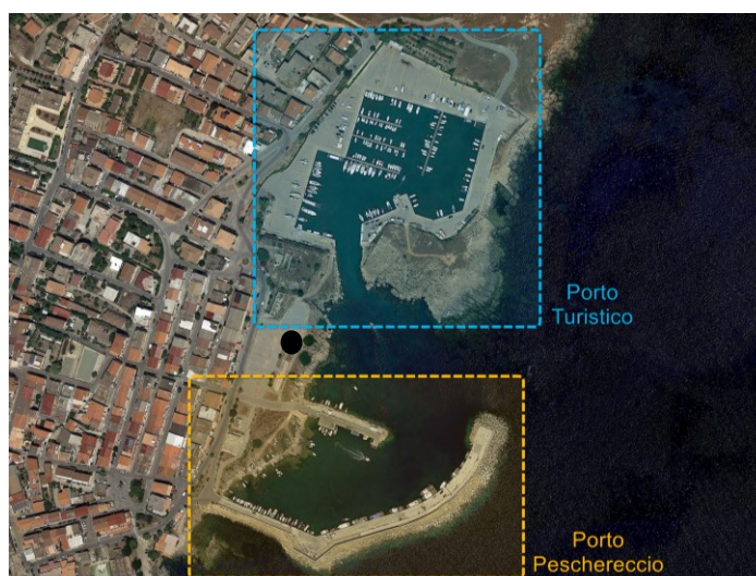
Foto 1: il sito di intervento
