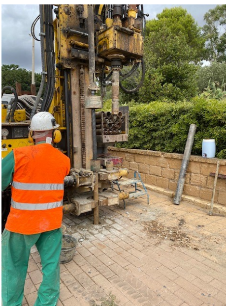
Foto n. 4 Esecuzione di prova SPT in sondaggio S5
