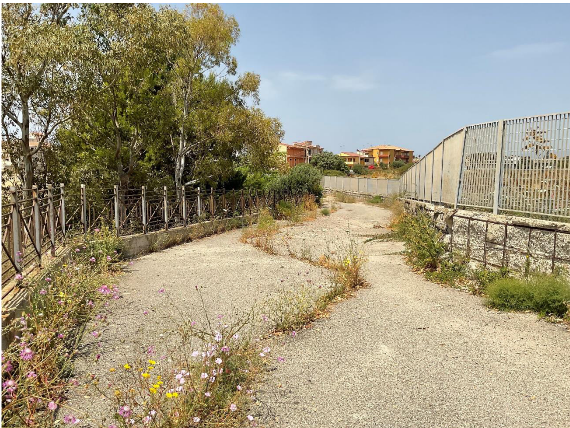
FOTO 18 - Viabilità esistente asservita al parcheggio
