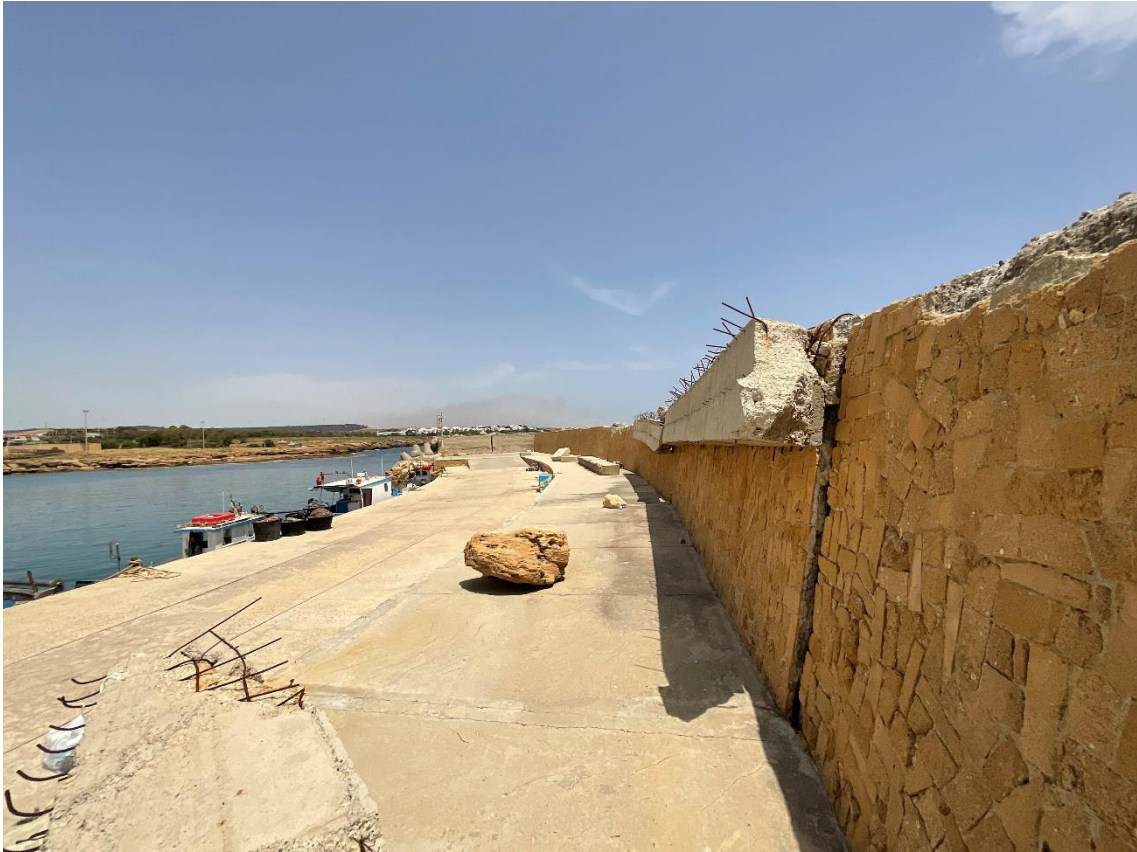
FOTO 13 - Testata molo di sopraflutto
