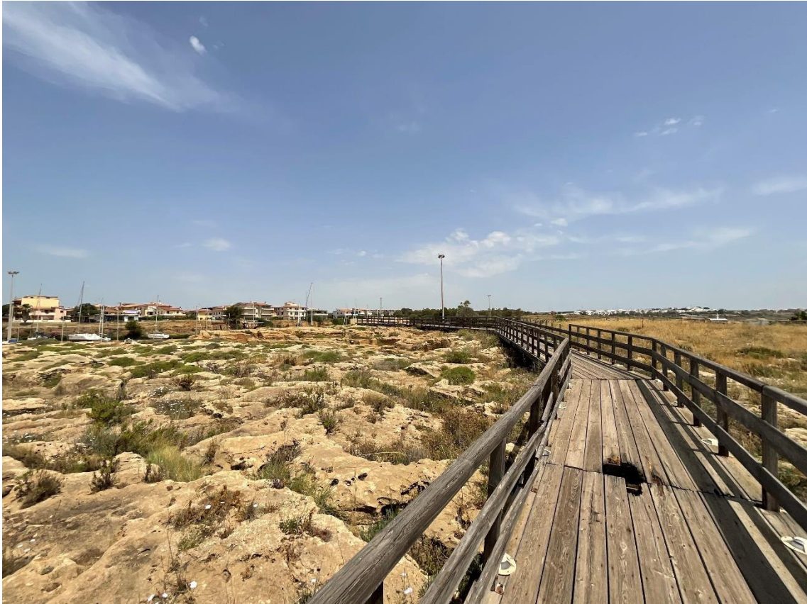
FOTO 9 - Percorso pedonale esistente
