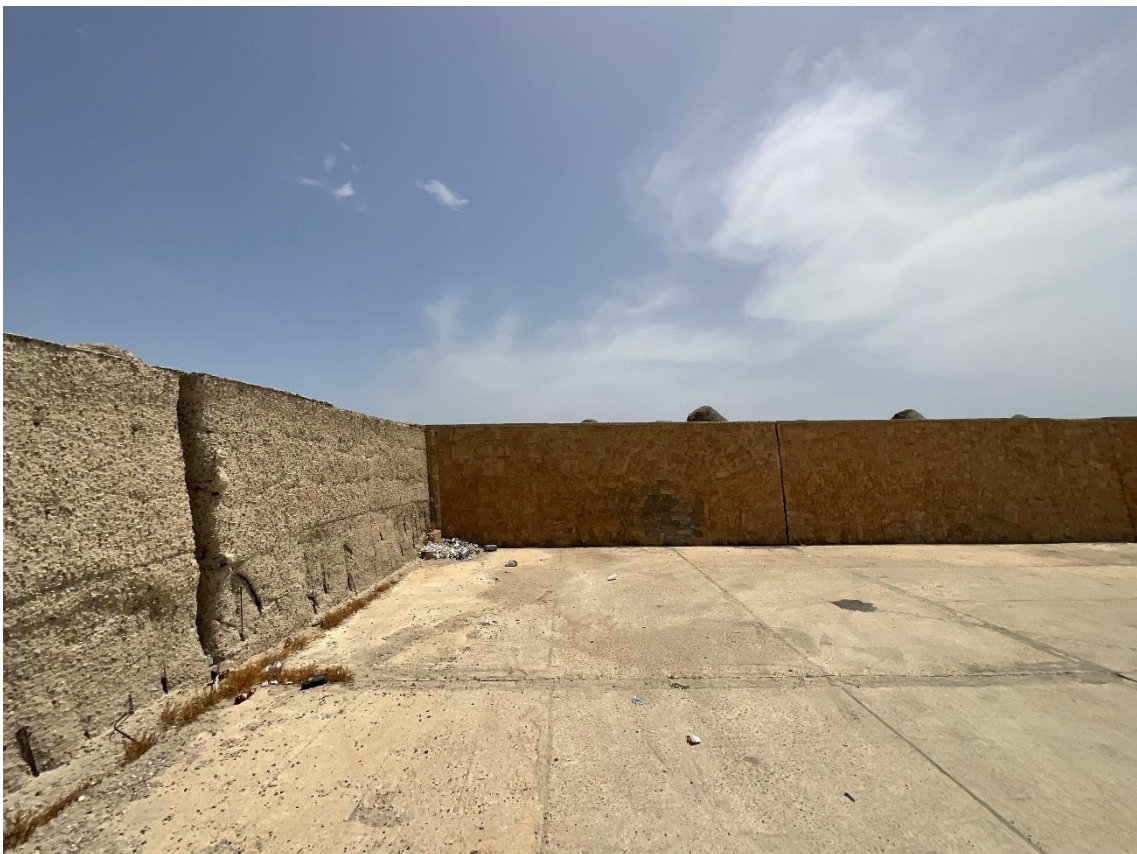
FOTO 14 - Porzione terminale molo di sopraflutto
