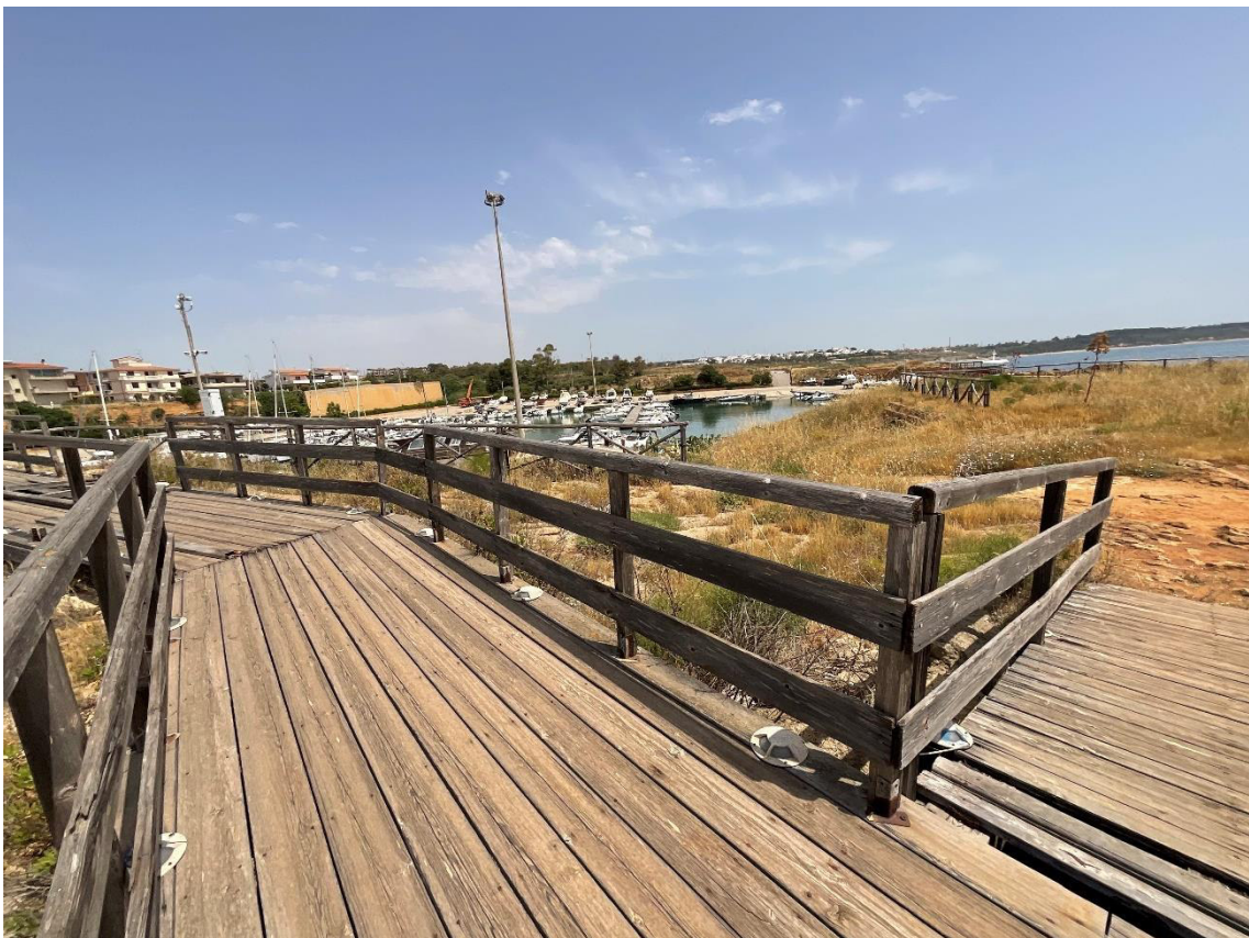
FOTO 8 - Percorso pedonale esistente
