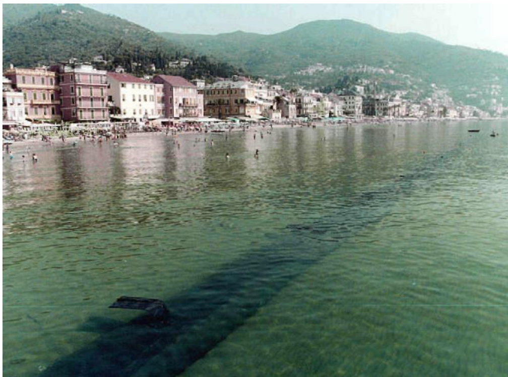
Figura 25-Esempio di barriere soffolte in opera.
