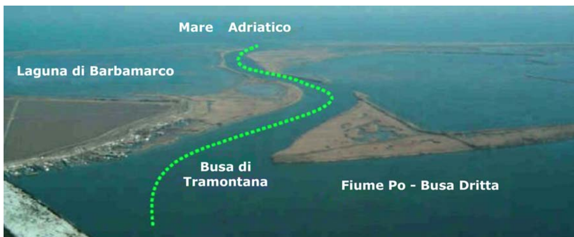
Figura 15 - La Busa di Tramontana vista dal camino della Centrale Enel di Porto Tolle. In verde è indicato schematicamente il percorso dal mare alla centrale Enel.
