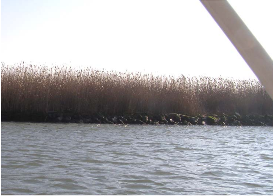
Figura 17 -Tipologia sponda della Busa di Tramontana: pietrame.
