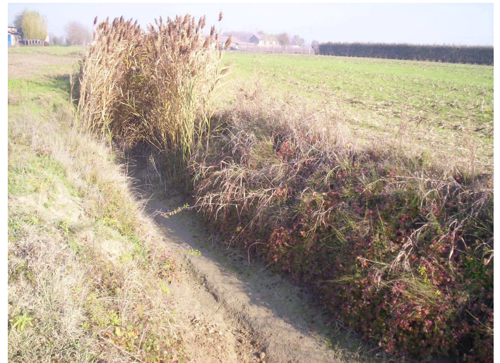
FIGURA 8-86: FOSSA REGGIANA ALTA IN CORRISPONDENZA DELL'ATTRAVERSAMENTO
