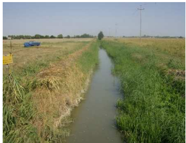
FIGURA 8-145: CAVO CANALAZZO NEL TRATTO DI INTERSEZIONE
