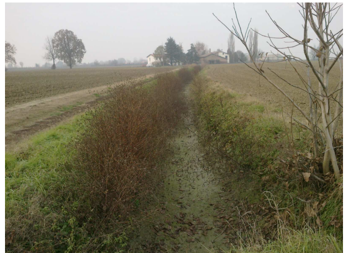
FIGURA 8-111: CAVO ALLACCIANTE SUBITO A VALLE DELLA BURANA
