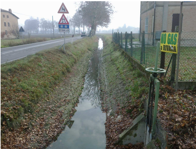
FIGURA 8-100: CAVO CANALINO IN CORRISPONDENZA ROTATORIA C07
