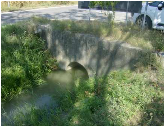
FIGURA 8-136: SCOLO SANT'ALÒ: PASSO CARRAIO
