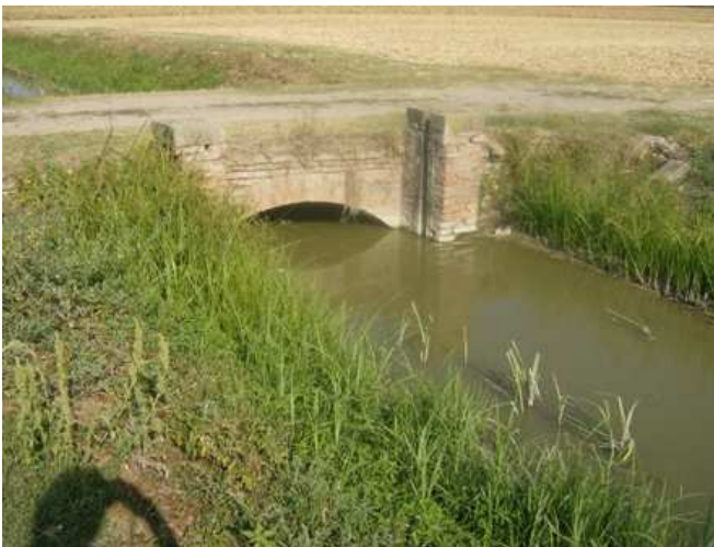
FIGURA 8-152: FOSSETTA VECCHI: PASSO CARRAIO IN MURATURA
