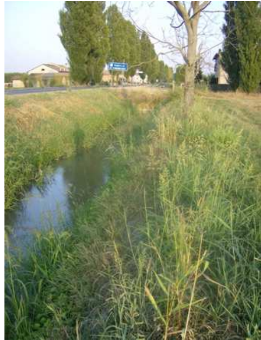
FIGURA 8-16: FOSSA CAVANA: ALLA SEZIONE D'INTERFERENZA, VISTA VERSO MONTE
