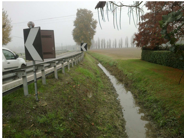
FIGURA 8-101: CAVO CANALINO IN CORRISPONDENZA ROTATORIA V27
