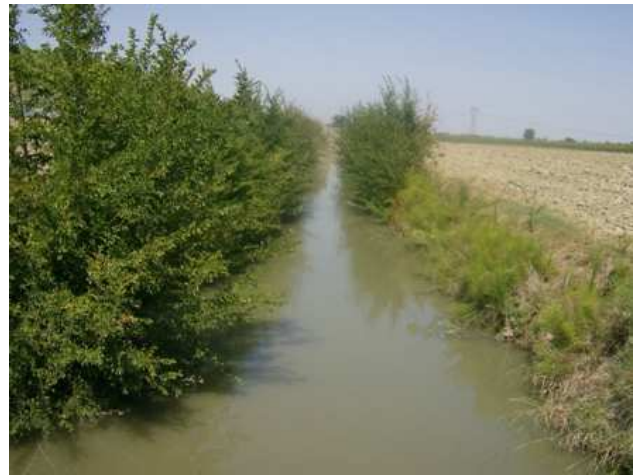
FIGURA 8-129: FOSSO LUNGO NEL TRATTO DI INTERSEZIONE
