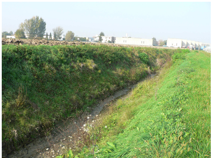
FIGURA 8-7: DUGALE ZALOTTA ALLA SEZIONE D'INTERFERENZA, VISTA VERSO MONTE
