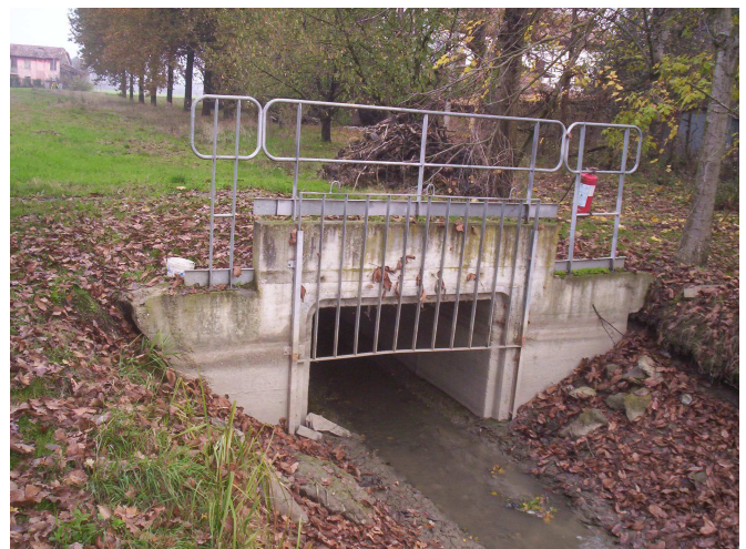
FIGURA 8-61: DUGALE CERESE: INIZIO TOMBOTTO A MONTE BURANA CON GRIGLIA SELETTIVA
