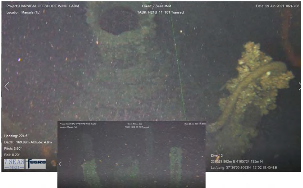
Figura 2.22: Frame dell'Ispezione Visiva registrata sul transetto H21S-11-T01 – testa di pozzo abbandonata
