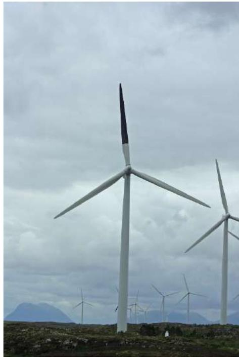
*Fig. 6.5.4/A -Esempio di una elica colorata di nero nel parco eolico di Smøla in Norvegia.*
