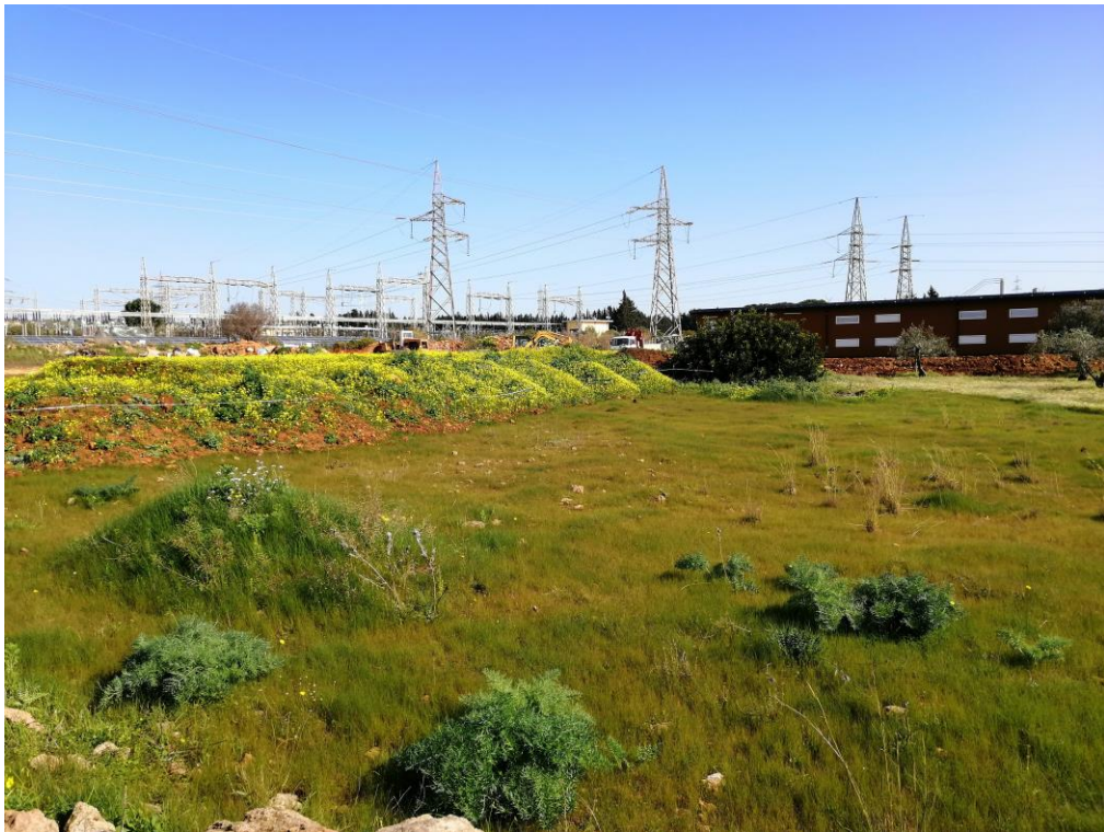
Figura 22: area sottoposta a ricognizione presso una sottostazione Terna, visibilità 0
