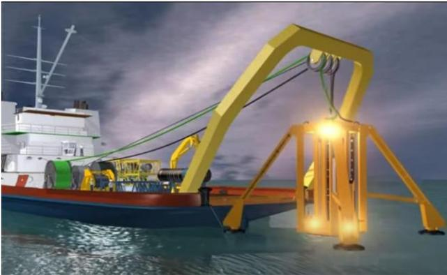
La prima fase di posa dei sistemi di ormeggio e dei relativi sistemi di ancoraggio al fondale marino è sostanzialmente identica per i sistemi turbina galleggiante e FOS eccetto per l'eventuale differente dimensione dei componenti. Ai fini della presente analisi si considera la condizione di calcolo più gravosa ipotizzando l'installazione di sistemi di ancoraggio a pali infissi.
