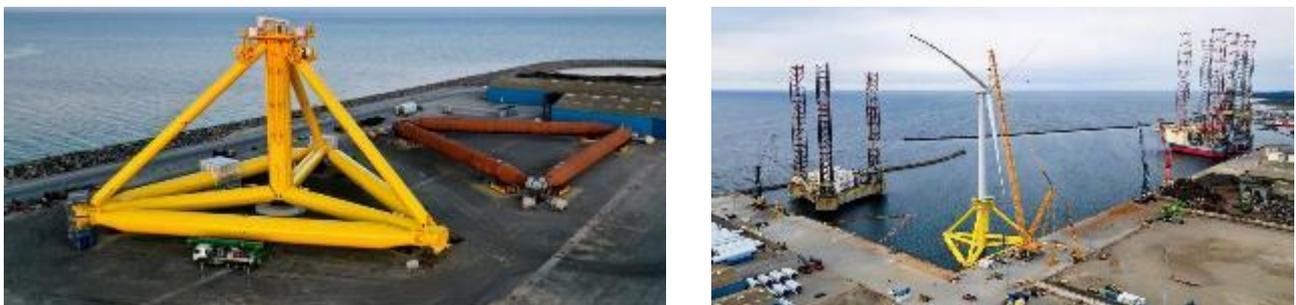
*Figura 7.13 – Esempio di assemblaggio di strutture galleggianti in aree portuali.*
