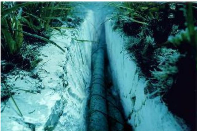
Figura 7.92 – Esempio di posa con tecnica di trenching chirurgico.
