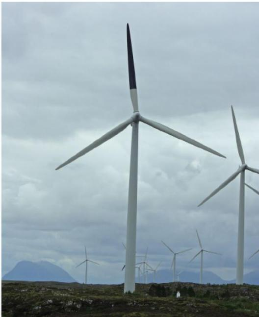
*Figura 12.5 – Turbina onshore con colorazione di una delle pale in nero.*
