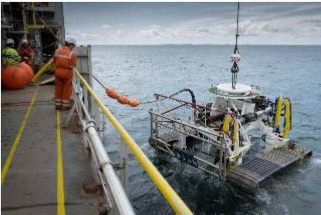
La posa dei cavi della rete inter-array viene effettuata, per ogni coppia di FOU, mediante apposita imbarcazione posa cavo (MPSV/AHTS) che procede alla stesura muovendosi da un generatore al successivo o verso la FOS. Previo collegamento elettrico su ciascuna FOU, con apposito mezzo di supporto, si procede quindi, in relazione alla strategia di protezione del cavo, all'applicazione eventuale di rocce/materassini o, mediante *trencher*, allo scavo, interrimento e ricopertura del cavo.
