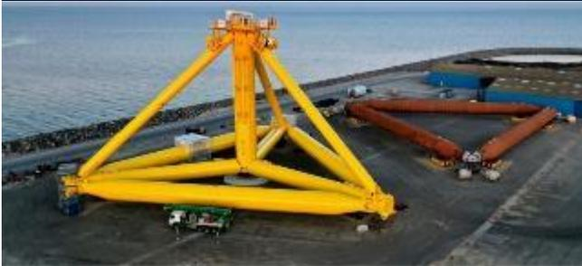
L'assemblaggio delle strutture di fondazione galleggianti è effettuato in area portuale presso banchina idoneamente strumentata.
