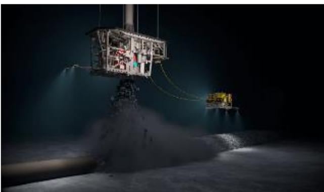
Figura 7.94 – Esempio di posa con protezione in massi naturali (rendering).
