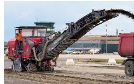
**Scarificazione dell'asfalto con fresatrice a freddo**
