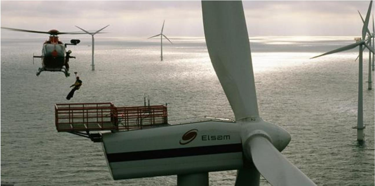
**Esempio di accesso alle strutture tramite elicottero**
