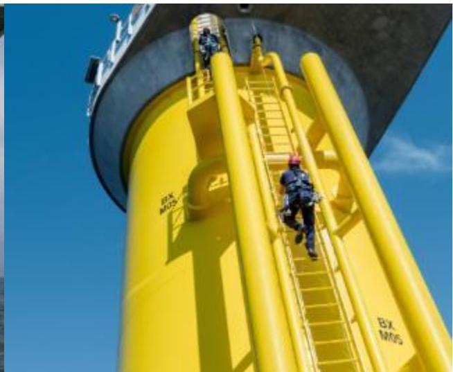
Sistema di accesso alle strutture mediante scala
