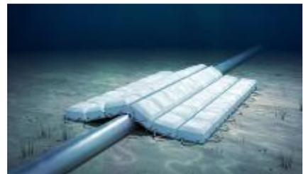
Esempio di posa con protezione a materassi in cls (rendering).
