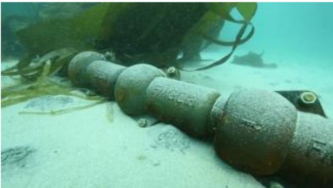
*Figura 7.98 – Esempio di posa con protezione in elementi modulari tubolari.
