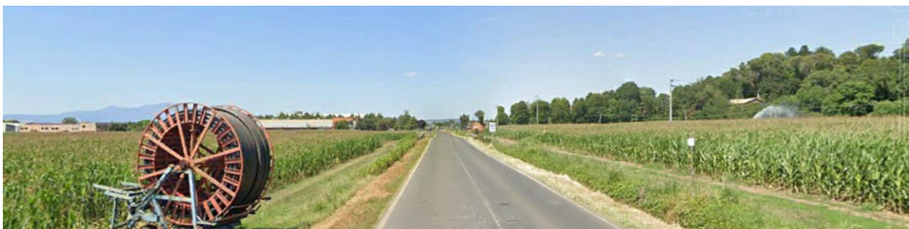
Figura 21- Strada Statale Cassia
