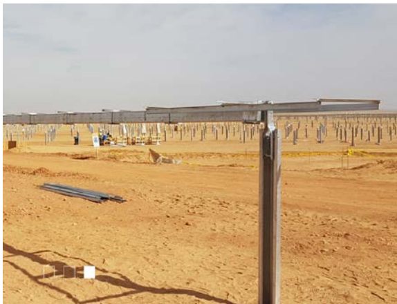
Fig. 7: Particolare inseguitore monoassiale ed attuatore
