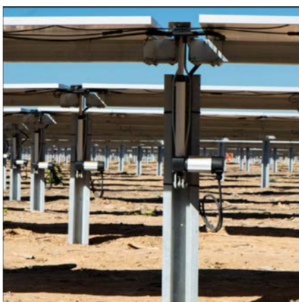
Fig. 7: Particolare inseguitore monoassiale ed attuatore
