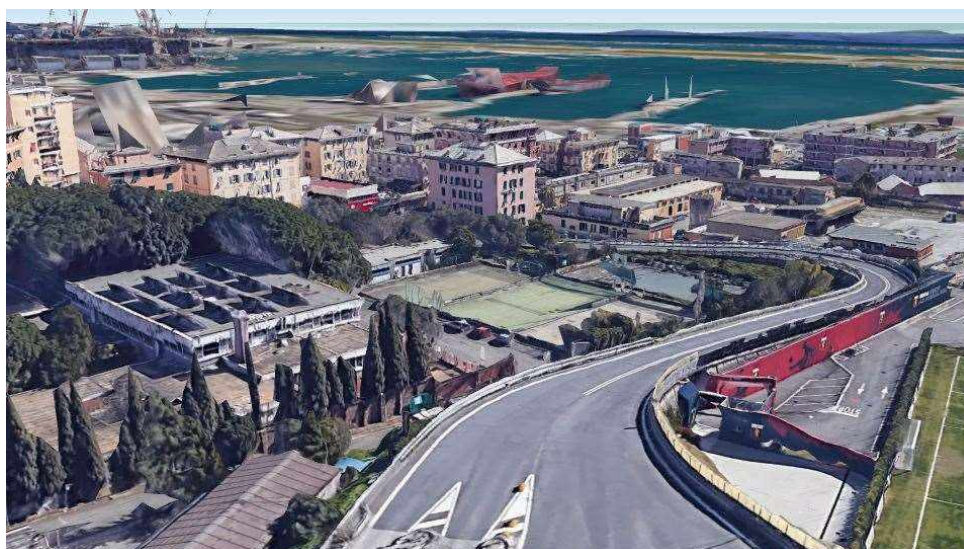
Figura 2-24. Vista aerea zona nord con il casello autostradale di Genova-Pegli, da nord-ovest
