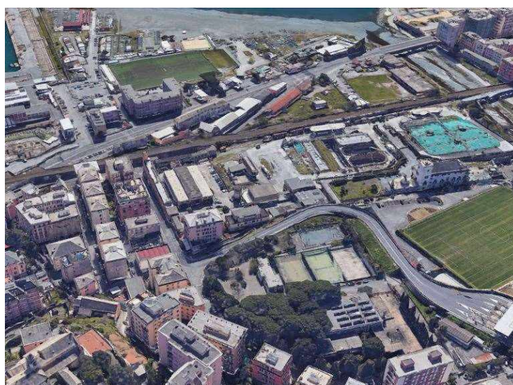
Figura 2-22. Vista aerea zona nord con il casello autostradale di Genova-Pegli, da nord
