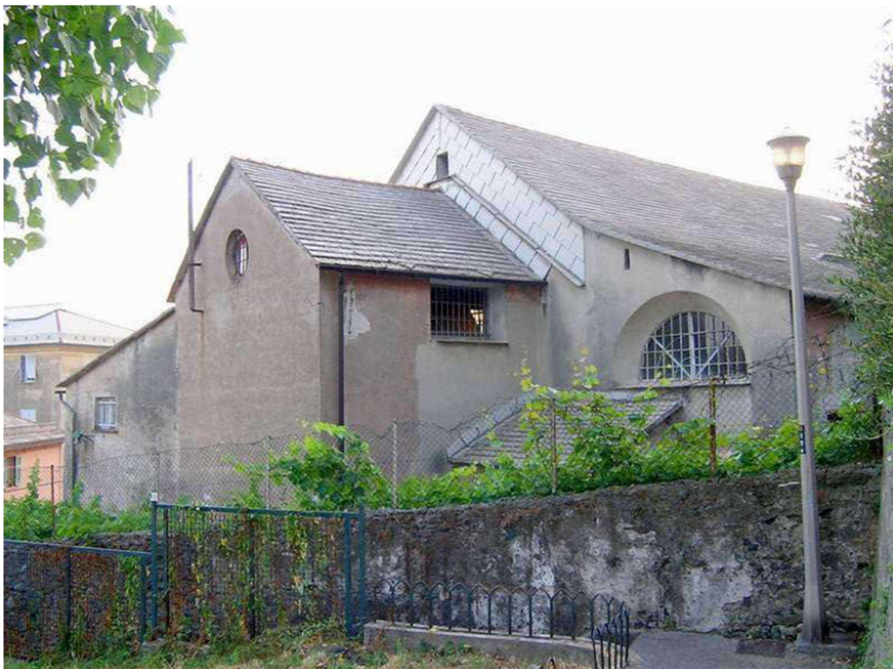
Figura 2-15. Foto dell'Oratorio dei SS. Nazario e Celso allegata al decreto di vincolo
