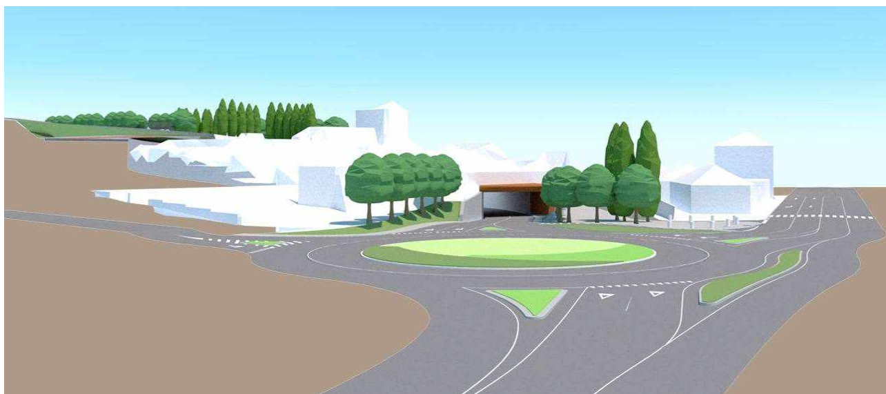
Figura 4-15. Intersezione con SS1 Aurelia e sullo sfondo l'imbocco sud della galleria artificiale
