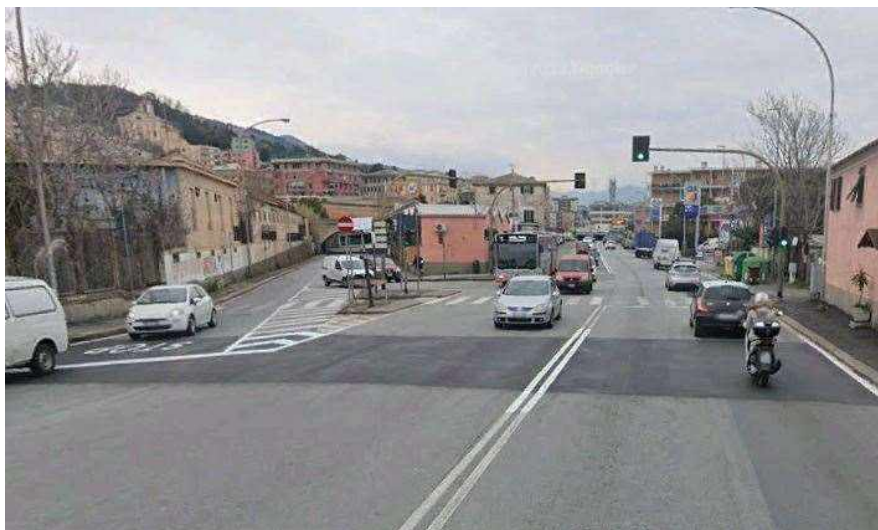
Figura 2-29. Vista stradale (da ovest) della zona di progetto sud, dove è prevista la nuova rotonda per l'immissione sulla Via Aurelia: sullo sfondo si vede l'area dove è previsto l'imbocco della galleria artificiale
