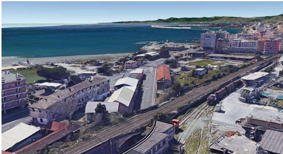
Figura 2-30. Vista aerea (da est) della zona di progetto sud: in primo piano la linea ferroviaria, sotto la quale transita la galleria artificiale dello svincolo di progetto. La prevista rotatoria sorgerà su un asse visivo verso mare.
