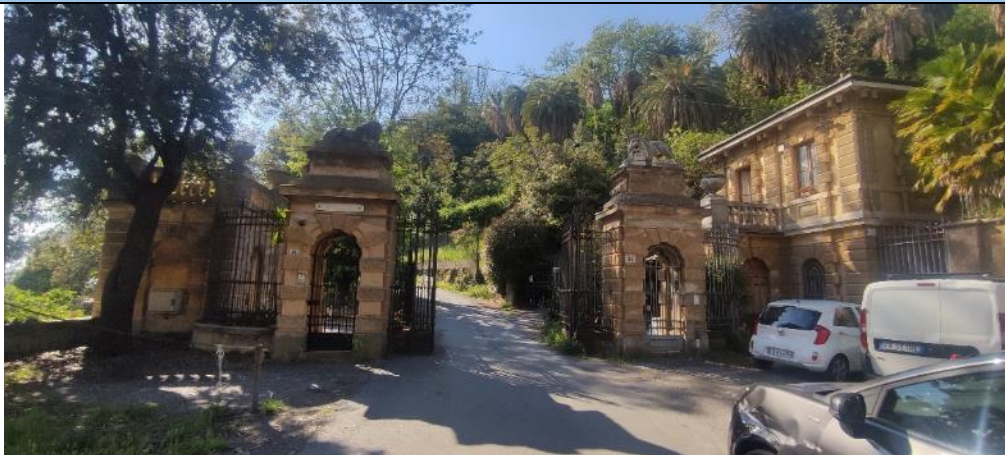
Figura 2-31. Ingresso Villa Chiesa (vista da viale Villa Chiesa)
