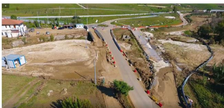
Figura 17 Danni alla sistemazione fluviale già realizzata ed alle viabilità secondarie e provvisorie
