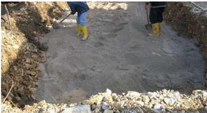
**FIGURA 6 - SBANCAMENTO PIANO POSA CABINE**
