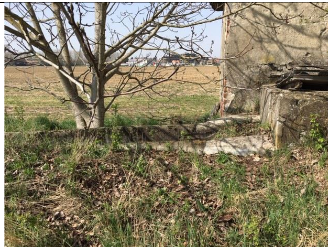
FIGURA 40 - FOTO DEL POZZO
