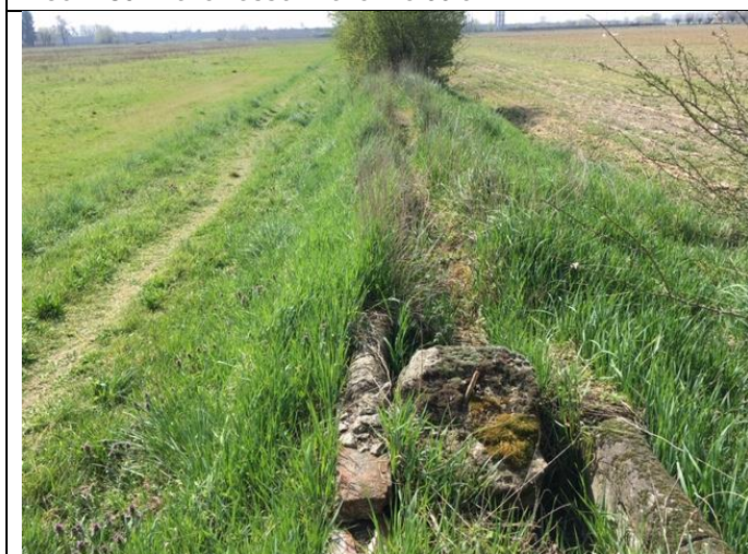
FIGURA 41 - FOTO DEL CANALE (IN PARTE INTERRATO)
