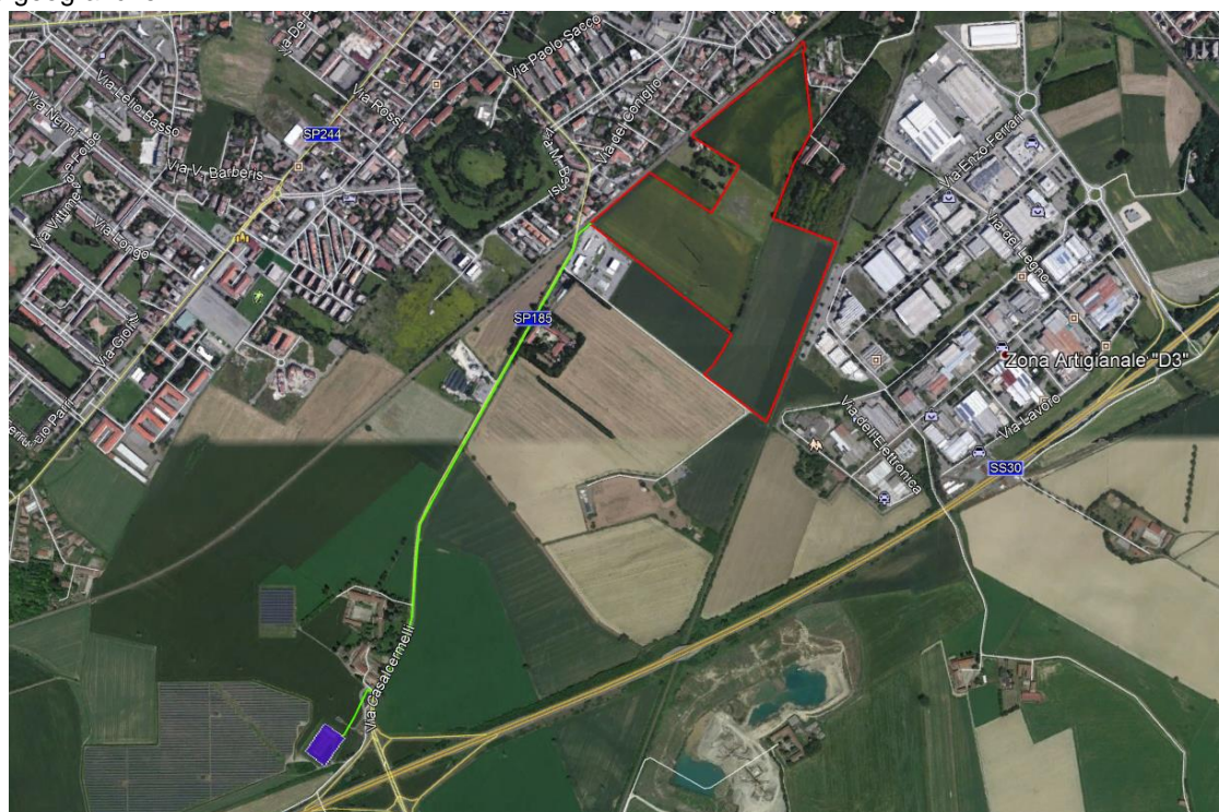
FIGURA 1 IMMAGINE SATELLITARI DELL'AREA OGGETTO DI INTERVENTO CON INDIVIDUAZIONE DELL'AREA DI INSTALLAZIONE DELL'IMPIANTO E DI CAVIDOTTO INTERRATO E CABINA DI CONSEGNA
