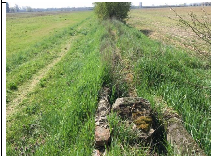
FIGURA 44 - FOTO DEL CANALE (IN PARTE INTERRATO)
