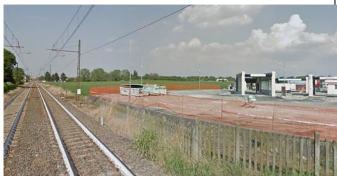
FIGURA 13 - VISTA 8 INCROCIO FERROVIA- VIA CASALCERMELLI
