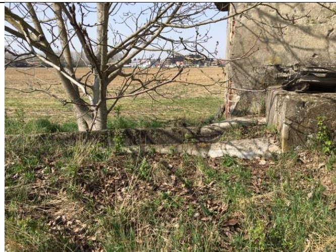
FIGURA 43 - FOTO DEL POZZO
