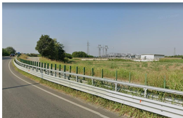
FIGURA 15 - VISTA 10 SP 185 - CABINA DI CONSEGNA
