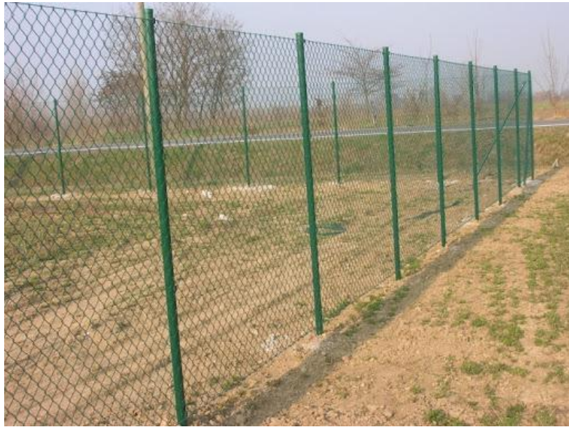
Figura 02- Esempio tipico della recinzione perimetrale
