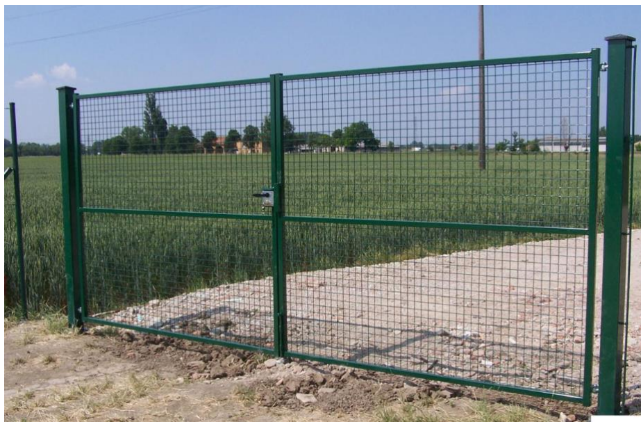
Figura 03- Esempio tipico cancello della recinzione perimetrale
