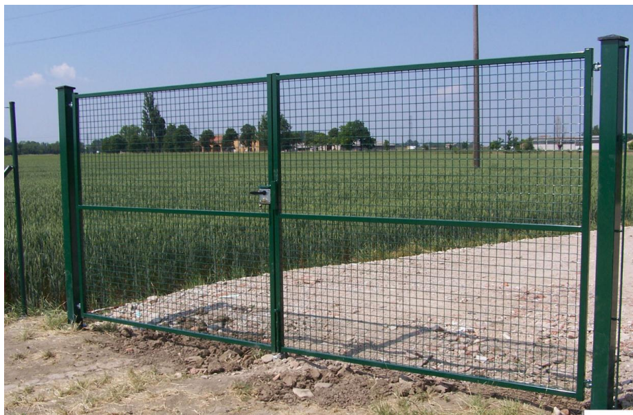
Figura 03- Esempio tipologico cancello della recinzione perimetrale
