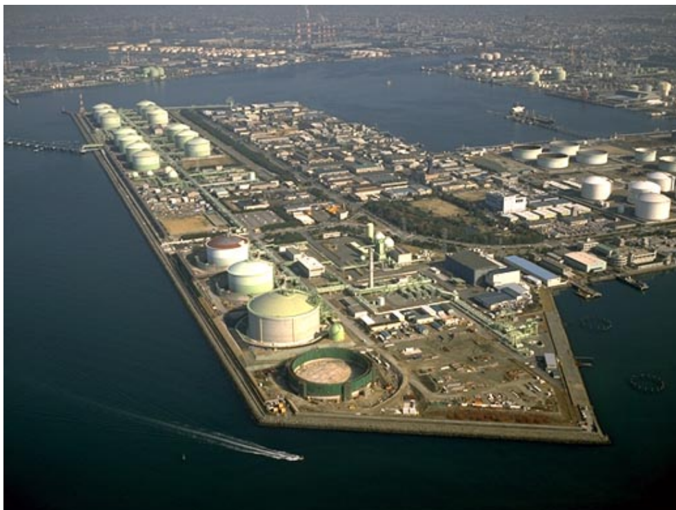
Senboku LNG terminal, 16 serbatoi
