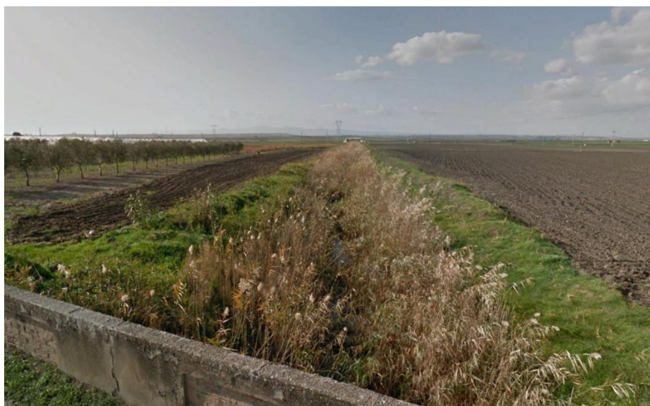
Figura 2.8: Canale S. Maria in corrispondenza dell'attraversamento sulla strada provinciale SP 20, circa 5 km a est dell'area di progetto.
