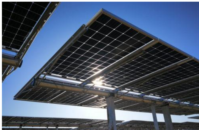
Figura 3.3 Esempio di struttura a tracker monoassiale
