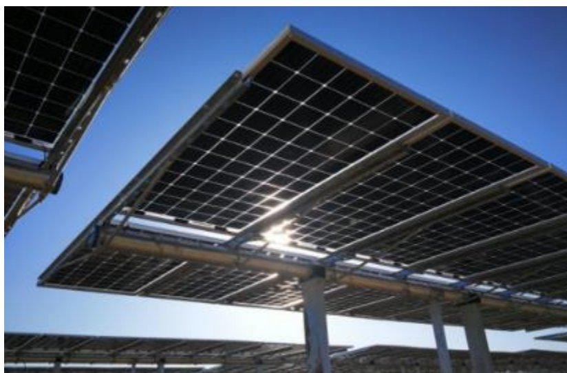
Figura 3.2: Esempio di struttura a tracker monoassiale
