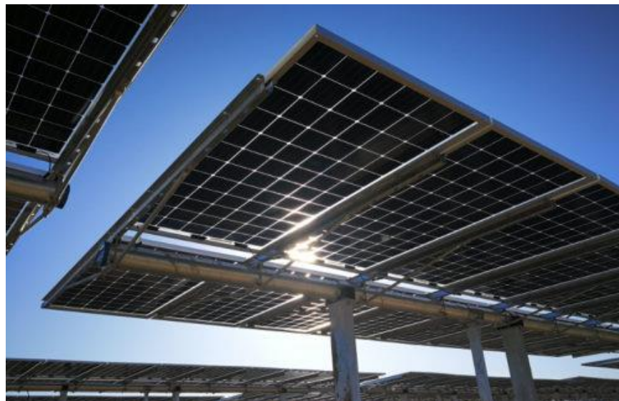
Figura 2.7 Esempio di struttura a tracker monoassiale
