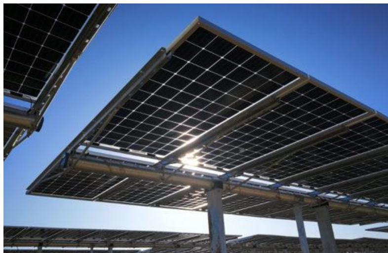
Figura 4.5 Esempio di struttura a tracker monoassiale
