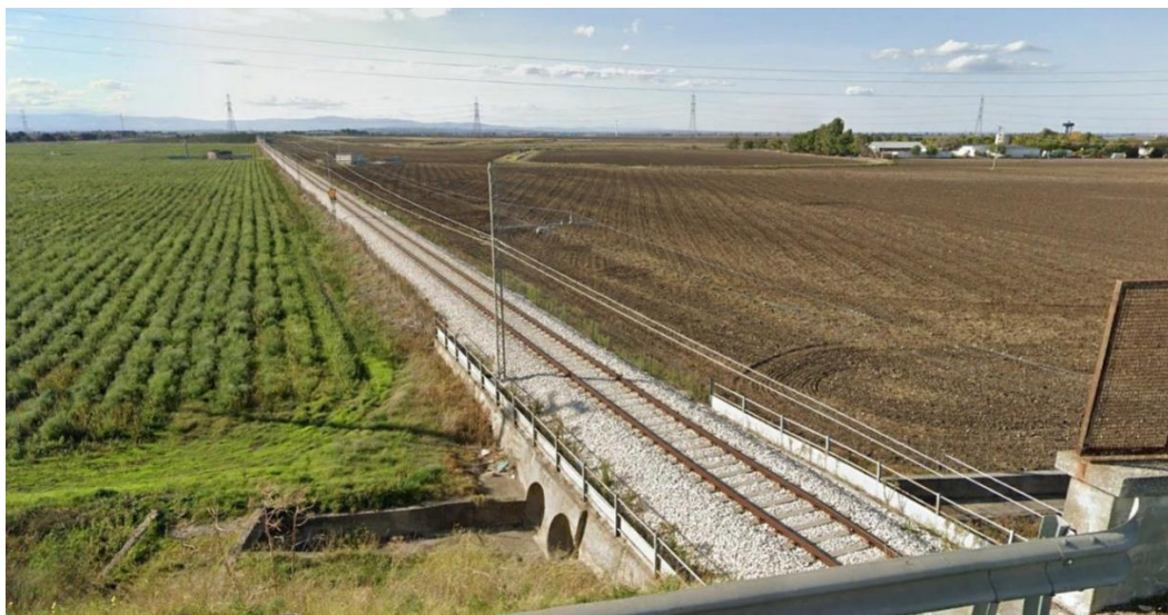
Figura 5.29: Attraversamento linea ferroviaria con strada statale SS673, stato di fatto 10/2020.
