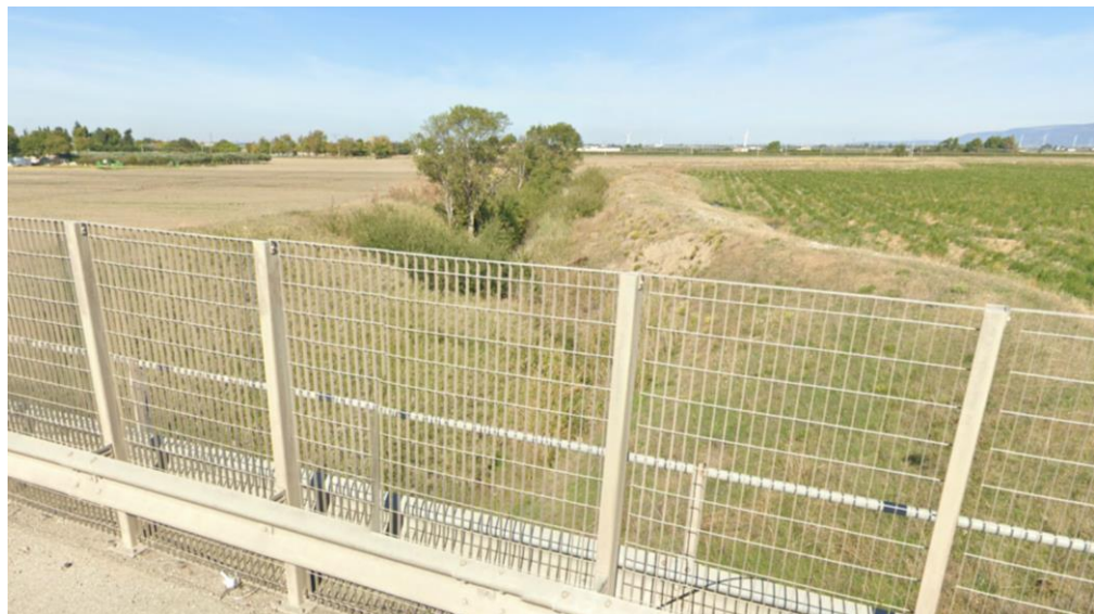
Figura 5.36: Interferenza P14, sezione T. Celone sovrappasso con SS673 al km 0,3. Vista verso valle.
