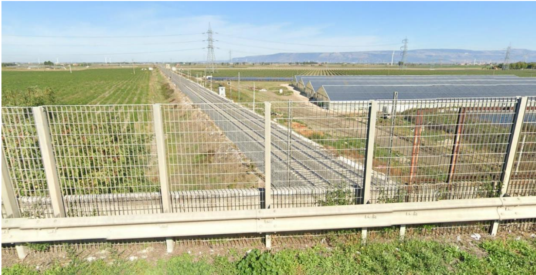
Figura 5.39: Attraversamento linea ferroviaria con strada statale SS673 km 1, stato di fatto 10/2020.
