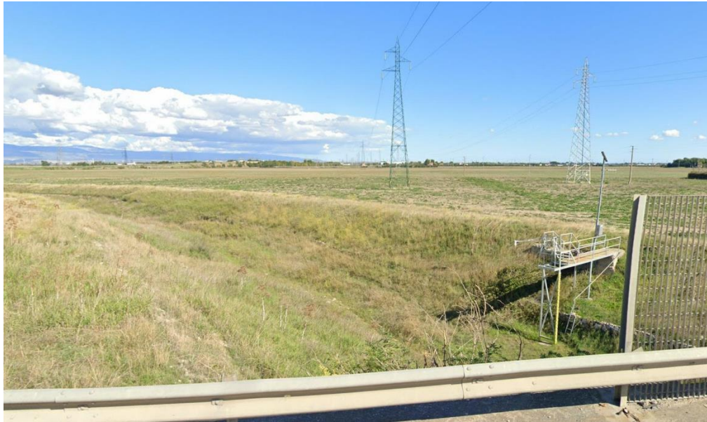
Figura 5.35: Interferenza P13, sezione T. Celone sovrappasso con SS673 al km 29,3. Vista verso valle.
