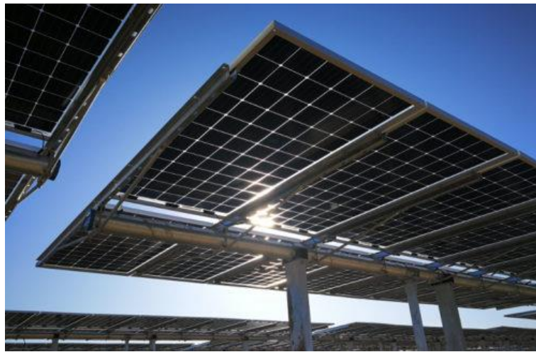
Figura 2.10 Esempio di struttura a tracker monoassiale
