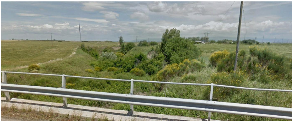
Figura 4.3.: Torrente Celone nei pressi del Sito
