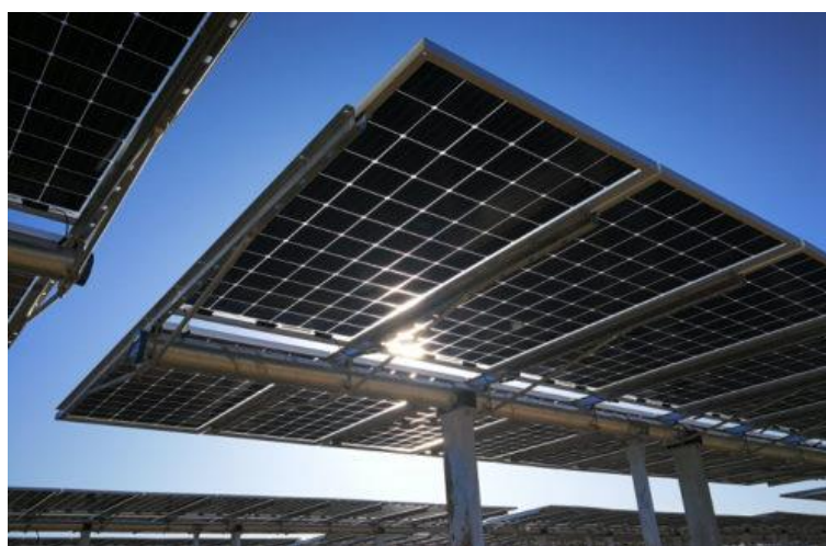
Figura 2.10 Esempio di struttura a tracker monoassiale
